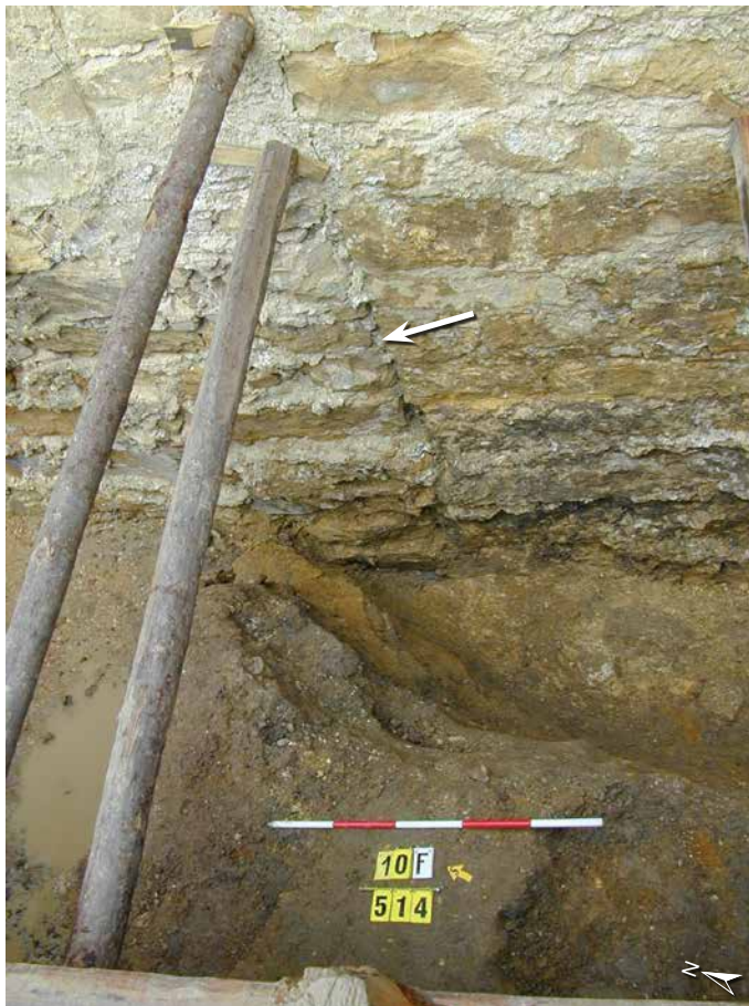
Obr. 42. Praha 1, Hradčanské nám. čp. 185/IV, základové zdivo; spára mezi jižní a severní částí východního křídla, šipkou poloha spáry (vyznačil F. Adámek, 2024; foto © Archeologický ústav AV ČR, Praha; G. Blažková, 2004).
