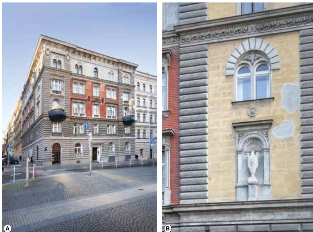
Obr. 21. Praha 2-Vinohrady, čp. 874, Slezská 36, Šumavská 35. A – průčelí do Slezské, B – průčelí do Šumavské ulice, detail niky (foto P. Havlík, 2023).
