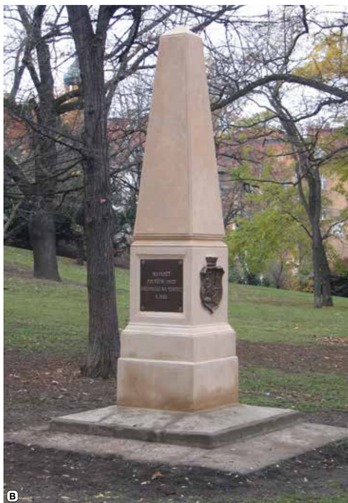
Obr. 4. Praha 10-Vršovice, Heroldovy sady. Pomník udělení městských práv Vršovcům. A – stav před poškozením (foto M. Ezechel, 2004; archiv m.č. Praha 10); B – stav po restaurování (foto archiv m.č. Praha 10, 2006).
