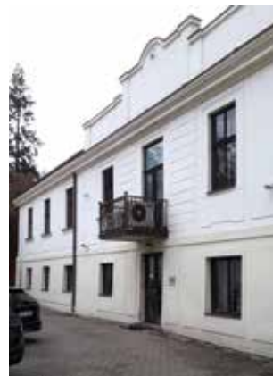
Obr. 12. Praha 9-Libeň, čp. 75, usedlost Kolčavka, dnešní hlavní průčelí postrádá původní empírové sloupy nesoucí balkon, dnes zmenšený, s vyměněným zábradlím (foto H. Čižinská, 2021).
