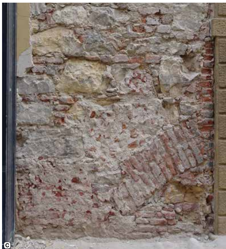
Obr. 9. Praha 1-Staré Město, čp. 234, Husova 8, dominikánský klášter. A – západní fasáda v Husově ulici po opravě (foto K. Knotová, 2023); B – odhalené opukové okenní ostění v 1. patře s dodatečně vysekanou polodrážkou pro vnější okno (foto K. Knotová, 2022); C – pas z cihel barokního formátu ve zdivu přízemí, snad porušený vložením vstupního portálu; dodatečné prolomení portálu je však diskutabilní z hlediska komunikačního schématu kláštera (foto K. Knotová, 2022); D – odhalené iluzivní armování nároží u průčelí kostela (foto L. Bartoš, 2022).
