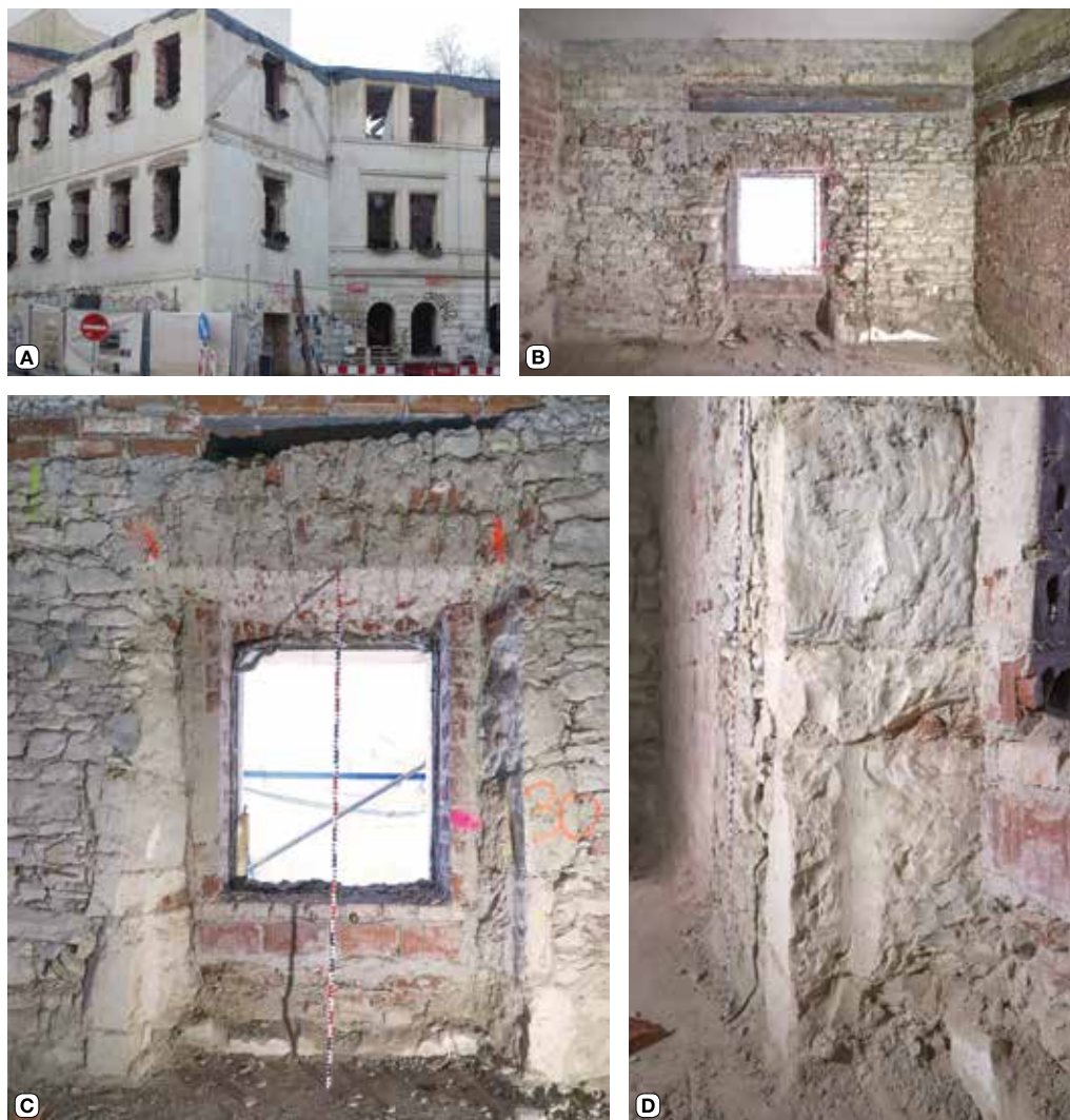
Obr. 11. Praha 2-Nové Město, čp. 1268, nároží ulic Na Rybníčku a V Tůních, bývalá kaple Všem svatých. A – celkový pohled na razantně přestavovaný objekt od severovýchodu (foto J. Sodomková, 2022); B – severní stěna prostoru v nároží domu v prvním patře, původně kaple; C – okno ve východní stěně prvního patra probourané v místě záklenku gotického východního okna kaple; v levé i pravé špaletě dochovány poškozené prvky kamenného ostění; D – detail severní opukové stojky a části pískovcového záklenku gotického východního okna kaple v prvním patře; na poškozeném prvku záklenku dochovány zbytky vápenných nátěrů (foto B–D L. Bartoš, 2022).
