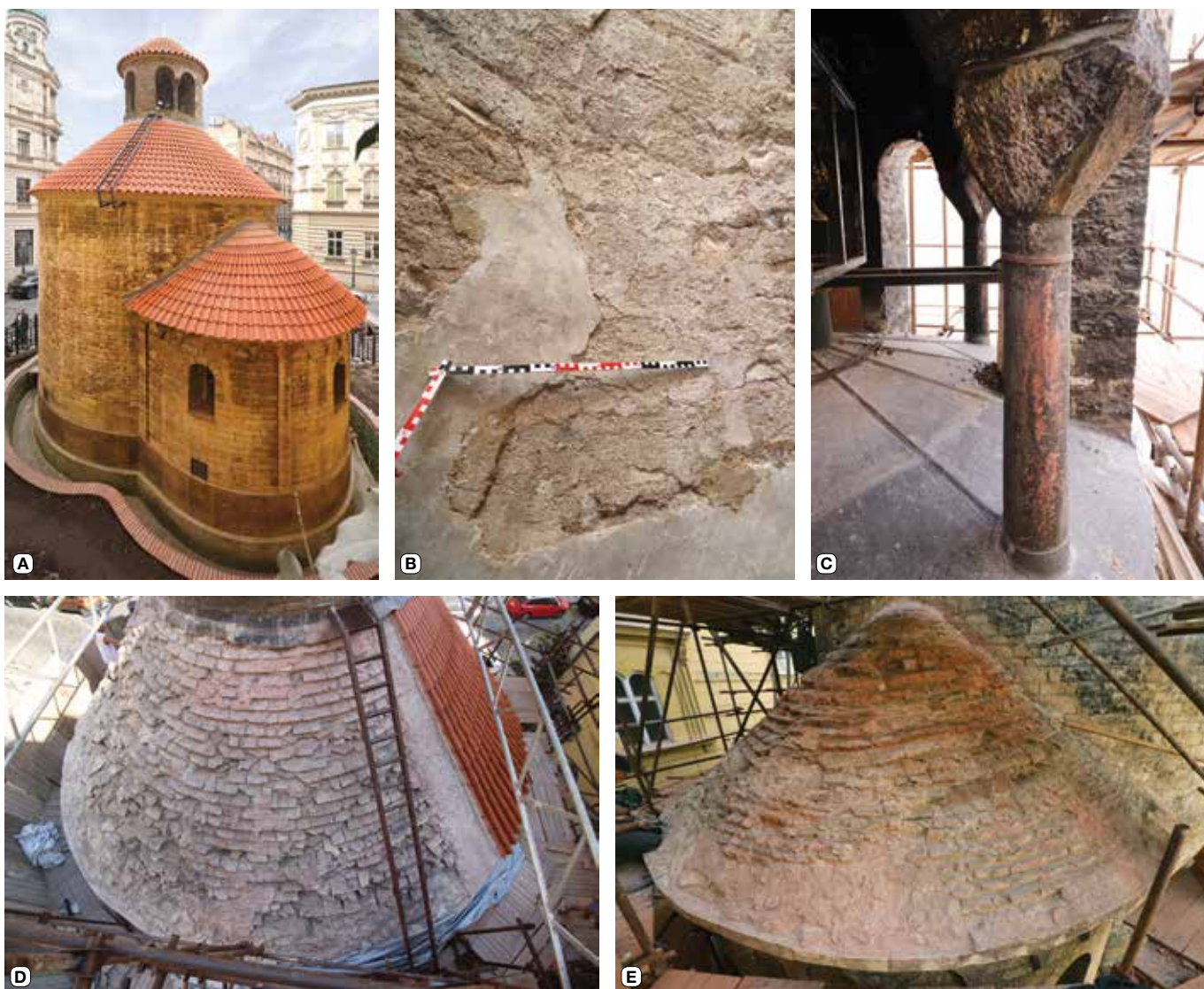
Obr. 3. Praha 1-Staré Město, Konviktská, Karoliny Světlé, rotunda sv. Kříže Menšího. A – celkový pohled na rotundu od východu (z okna domu čp. 1013/I) po dokončení obnovy střešního pláště (foto L. Bartoš, 2023); B – detail části vnitřního líce kupole během opravy omítek s viditelnými otisky původních prken bednění (foto L. Bartoš, 2022); C – jeden ze sloupků sdružených oken lucerny s viditelnými pozůstatky barevných nátěrů (foto L. Bartoš, 2022); D – odkrytá původní kamenná střešní krytina na jižní straně lodi (foto A. Piskáčková, 2022); E – odkrytá původní kamenná střešní krytina apsidy s větším rozsahem oprav pálenými prvky (foto L. Bartoš, 2022).
