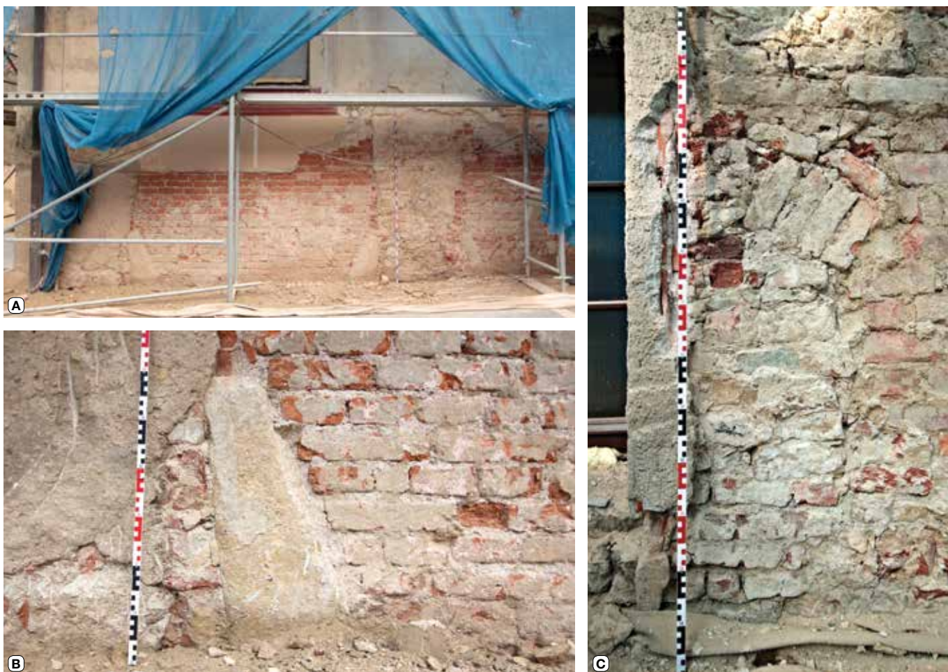
Na dvorní fasádě zadního (severního) renesančního křídla byly na straně do hlavního dvora zaznamenány záklenky starších okenních otvorů. Ve čtyřech případech se zde nacházejí zazdívky nižších otvorů (dokumentovatelná výška okolo 70 cm; obr. 1C) s cihelným záklenkem, které mohly náležet buď nízkým širokým (širším než současná okna) otvorům umístěným v okenní ose, nebo eventuálně užším otvorům umístěným mimo okenní osu. V jednom případě byl dokumentován široký cihelný záklenek nad současným otvorem (odhadovaná šířka okolo 180 cm).
