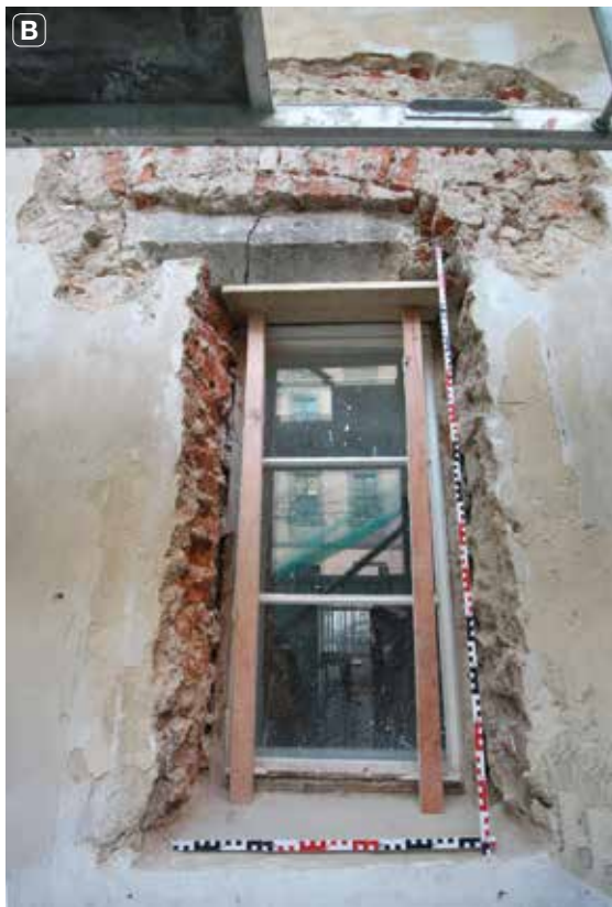
Obr. 8. Praha 1-Staré Město, čp. 135, Linhartská 4. A – okenní otvor v 1. okenní ose, druhotně použité kamenné stojky s okosením, cihelný záklenek s omítkou imitující kámen a cihelný parapet; B – okenní otvor ve 2. okenní ose, kamenné nadpraží s okosením; C – detail nadpraží z obr. B s vyznačením hran okosení, které pravoúhle přechází do okosení nedochovaných stojek (foto A: A. Piskáčková, 2020; B+C: K. Knotová, 2020).
