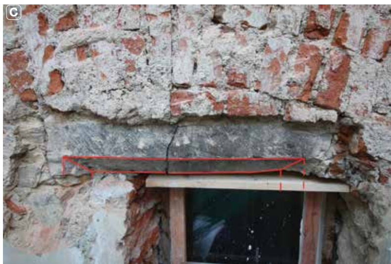
Obr. 8. Praha 1-Staré Město, čp. 135, Linhartská 4. A – okenní otvor v 1. okenní ose, druhotně použité kamenné stojky s okosením, cihelný záklenek s omítkou imitující kámen a cihelný parapet; B – okenní otvor ve 2. okenní ose, kamenné nadpraží s okosením; C – detail nadpraží z obr. B s vyznačením hran okosení, které pravoúhle přechází do okosení nedochovaných stojek (foto A: A. Piskáčková, 2020; B+C: K. Knotová, 2020).
