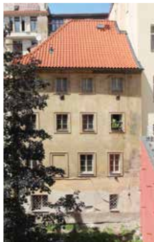
Obr. 7. Praha 1-Staré Město, čp. 135, Linhartská 4. Dvorní fasáda, stav před opravou (foto K. Knotová, 2020).
