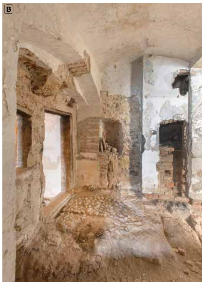
Obr. 6. Praha 1-Nové Město, čp. 1113, Truhlářská 8. A – jihozápadní stěna černé kuchyně s portálem a výdejním oknem; B – černá kuchyně s odkrytým souvrstvím podlah (foto P. Havlík, 2019).
