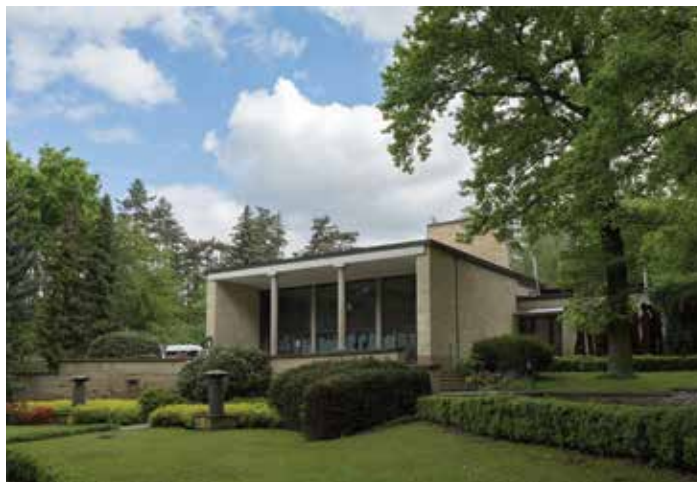
Obr. 5. Praha 5-Motol, čp. 30, Krematorium Motol. Pohled na hlavní průčelí (foto M. Kracík, 2021).
