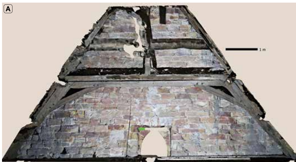
Obr. 9. Praha 14-Kyje, kostel sv. Bartoloměje. A – východní štít lodi od západu, místo nálezu zbytku desky šalování, datované po roce 1214, vyznačeno zeleně ; B – východní štít lodi od východu, část nad presbytářem, vazba krovu presbytáře z doby kolem roku 1509 (prostorový model M. Semerád; úprava L. Bartoš, 2021).
