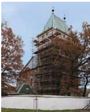
Obr. 8. Praha 14-Kyje, kostel sv. Bartoloměje. Pohled na kostel od severozápadu v průběhu opravy fasád věže (foto L. Bartoš, 2020).
