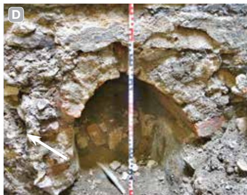
Obr. 2. Praha 1-Hradčany, čp. 174, Loretská 3. A – měřená skica stoky; B – výkop se stokou v základovém zdivu východního dvorního křídla, pohled od západu; C – pohled do stoky od západu, po stranách (šipkami) viditelná vymazávka korytky, vzadu zával; D – řez fragmentem stoky v líci fasády od západu, vlevo patrná spára (šipkou) po druhotném vestavění stoky do zdiva (foto a kresba K. Knotová, 2020).
