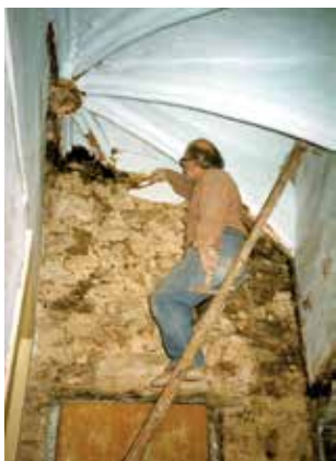
Práce na kostele sv. Jana – Work on the chapel of St. John, 1998.
