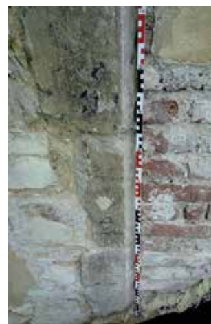
Obr. 11. Kostel sv. Apolináře. Fragment ostění zazděného hrotitého okna v západní stěně kostela v průběhu obnovy omítky (foto L. Bartoš, 2019).
