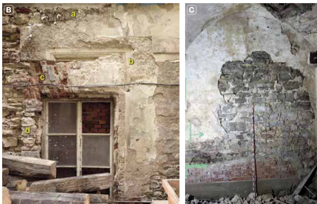
Obr. 8. Celetná čp. 553/I. Západní dvorní objekt. A – foto od severu, stav během rekonstrukce; B – první patro; náleзовé situace v jižní části dvorní fasády s částečně dochovaným ostěním goticko-renesančního okna in situ ; a – cihlový vylehčovací záklenek; b – profilovaný kamenný překlad a část stojky ostění in situ (vystupující část profilace odsekána); c – vložený cihlový záklenek klasicistního okna; d – druhotně vyzdělá špaleta mladšího okna v místě někdejšího ostění okna původního; C – přízemí, částečně odhalené zdivo jihozápadní obvodové zdi z břidlice, kterou objekt sousedí s domem čp. 1094 (foto K. Kalousková, A+B: 2019, C: 2020).
