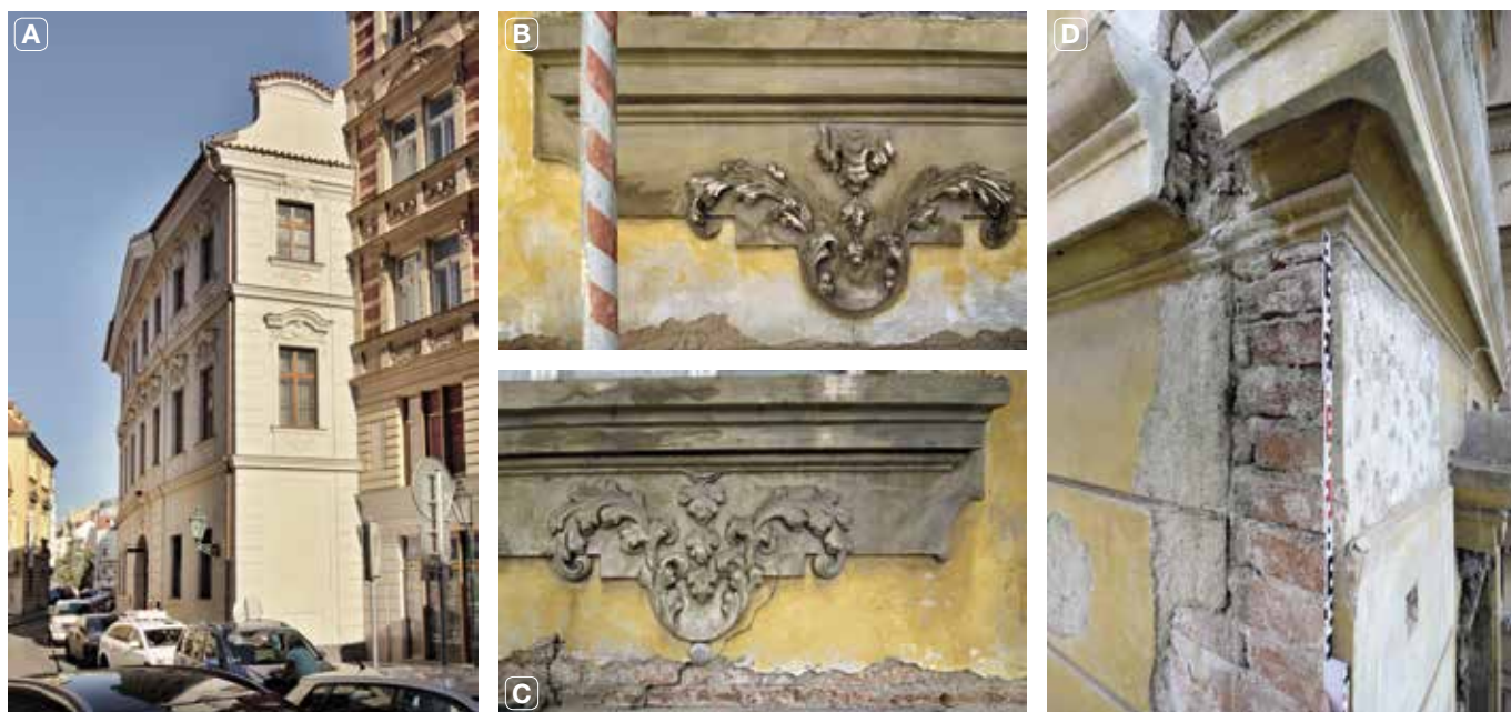
Obr. 10. Štupartská čp. 598/I. Fasáda zadního uličního křídla. A – stav po rekonstrukci, pohled od západu; B, C – porovnání štukové výzdoby okenních šambrán: barokní ( B ) a novodobé ( C ); D – detail cihelné plenty na bočním úseku fasády (foto K. Knotová, 2019).
