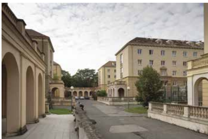
Obr. 8. Praha 4-Podolí, čp. 772, Koleje ČVUT. Pohled od východu (foto M. Kracík, 2020).
