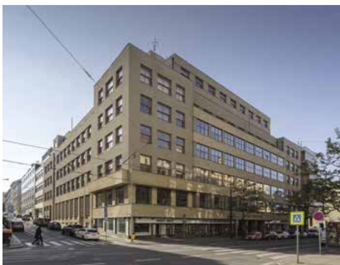
Obr. 5. Praha 2-Vinohrady, čp. 1409, budova Československého rozhlasu. Pohled od severovýchodu z Vinohradské ulice (foto M. Kracík, 2020).
