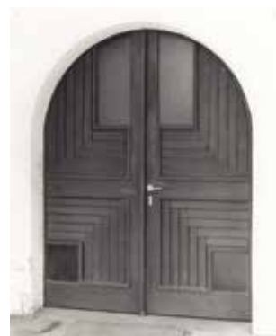
Dveře do domu čp. 17 v podloubí náměstí Přemysla Otakara II. v Českých Budějovicích podle Stormova návrhu v rámci rekonstrukce parterů domů v letech 1970–1977 (neznámý fotograf).
