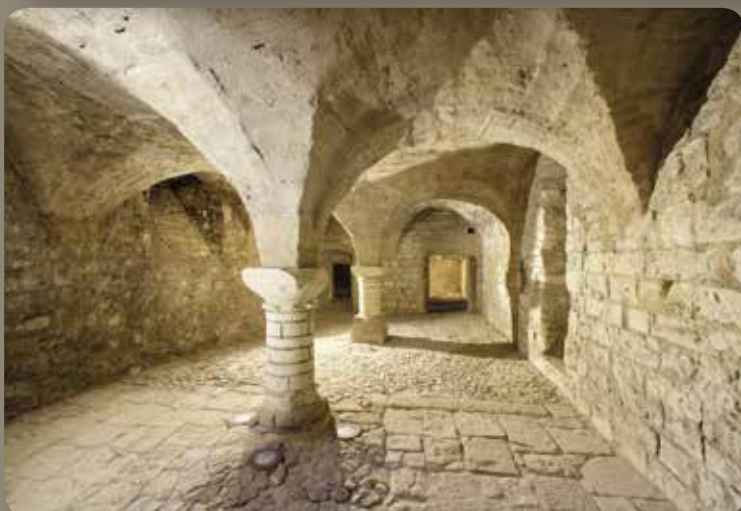
Staré Město (Zd. Dragoun, M. Tryml). Hlavní prostor spodního podlaží paláce pánů z Kunštátu a Poděbrad v Řetězové ulici. Hlavní sál je zaklenut šesti poli křížové klenby na dva sloupky. V rozích paláce se dochovaly relikty krbů. Stavba patří k nejkrásnějším, největším a nejlépe zachovalým kvádřikovým domům v Praze. Právě v horních podlažích tohoto objektu sídlil po mnoho let archeologický odbor pražských památkářů.
