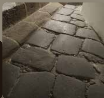
Malá Strana (Zd. Dragoun). Pozůstatky Juditina mostu byly objeveny v jednom z domů v ulici U lužického semináře. Nalezenou unikátní dlažbu z tmavých ohlazených diabasových kamenů a část zábradlí z pískovcových kvádrů se podařilo zpřístupnit.
