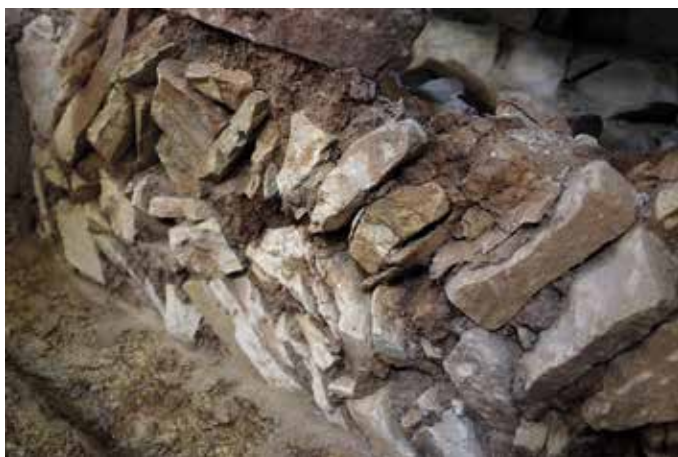
Obr. 3. Praha 8-Dolní Chabry. Kostel sv. Jana Křtitele. Základové zdivo druhé nejstarší stavby (foto M. Pavýza, 2014).
