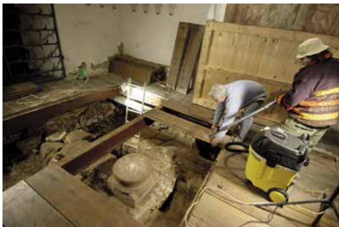
Obr. 2. Praha 8-Dolní Chabry. Kostel sv. Jana Křtitele. Odstraňování podlahových desek v patřích nad patkou románského sloupu. Snímek dobře ukazuje zvolený způsob zastropení (foto M. Tryml, 2010).
