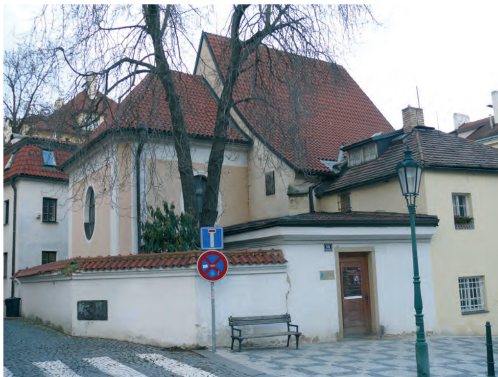
Obr. 8. Praha 1-Malá Strana, bývalý kostel sv. Vavřince, dnes čp. 553. Generální oprava kostela probíhala od roku 1984, stavební část vedl arch. J. Hyzler. Došlo k obnově architektonických prvků, restaurování nástěnných maleb a k obnově vrcholně gotického zastřešení podle ikonografických pramenů. Arch. Hyzler ještě vyprojektoval drobnou administrativní stavbu u barokního presbytáře (foto J. Krátký, 25. 11. 2010).
