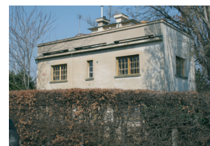
Obr. 9. Praha 6-Břevnov, Rothmayerova vila, čp. 896. Pohled z ulice od jihovýchodu (digitální fotoarchiv NPÚ HMP, foto K. Fink, 2007).
