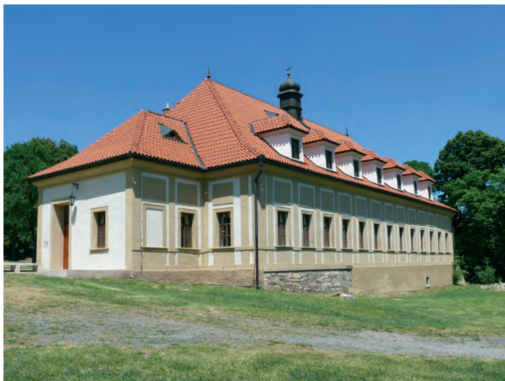
Obr. 9. Mníšek pod Brdy, znovuzrozená rezidence františkánů. Arch. Hyzler se podílel na celkové rehabilitaci areálu kláštera od 80. let 20. stol. (foto J. Hájek, 12. 6. 2010).
