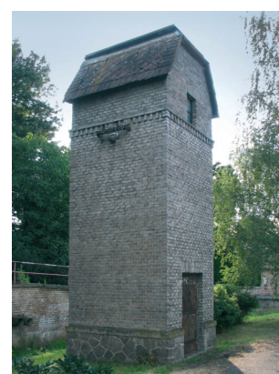
Obr. 13. Praha 22-Nedvězí, trafostanice (digitální fotoarchiv NPÚ HMP, foto A. Křížová, 2008).
