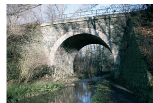
Obr. 14. Praha 22-Uhřetěves, železniční viadukt nad Říčanským potočkem. Pohled od jihu (digitální fotoarchiv NPÚ HMP, foto K. Fink, 2006).
