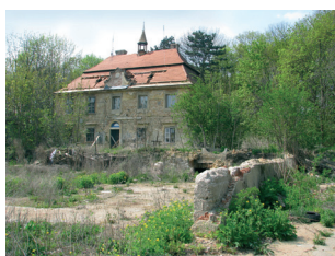
Obr. 16. Praha 20-Horní Počernice, areál zámku Čertousy čp. 82. Pohled od jihovýchodu na budovu zámku čp. 82, v popředí demolované hospodářské objekty (digitální fotoarchiv NPÚ HMP, foto J. Baláček, 2010).
