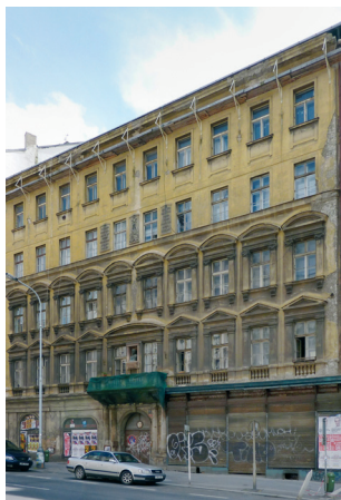
Obr. 4. Praha 2-Nové Město, čp. 564, nájemní dům U Bílého lva, dům spjatý s pobytem Antonína Dvořáka. A) Uliční fasáda do Žitné ulice (foto Petr Vaňous, červen 2010, NPÚ HMP). B) Orientační plán areálu (vytvořil Vratislav Nový, 2010).
