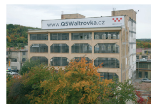
Obr. 7. Praha 5-Jinonice, budova bývalé továrny Walter, čp. 329. Pohled od jihu (digitální fotoarchiv NPÚ HMP, foto K. Fink, 2008).
