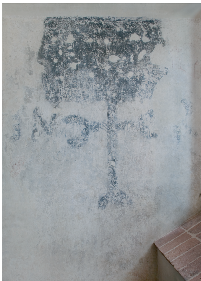
Obr. 8. Praha 1-Hradčany, Schwarzenberský palác, čp. 185, Hradčanské náměstí 2. Místnost č. 1S10, suterén, celek levé špalety levého okna (foto P. Havlík, 2010).
