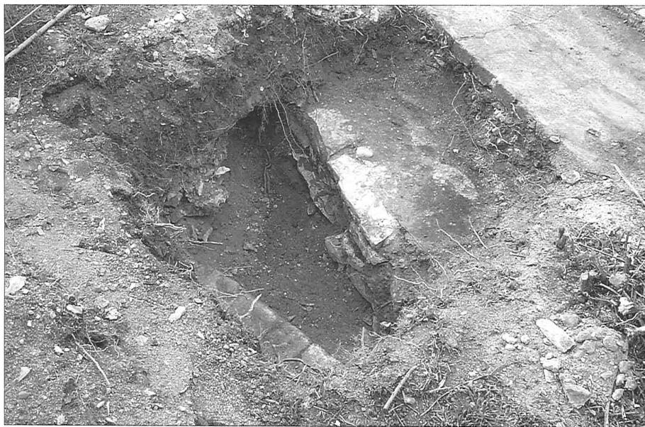
Obr. 14: Archeologická sonda 9, jejíž hloubka byla limitována podmínkami rekonstrukce zdi bastionu, odkryla v jižní pravé části patrné opěrné zdivo z lomové opuky s výskytem cihel. Linie zdiva je orientována přibližně rovnoběžně k pokračování gotické hradby a nesouvisí stavebně s kamennou plentou, jež byla nalezena rovněž v sondách 1, 2 a 10. Nálezová situace nevylučuje v tomto místě využití staršího gotického tělesa, které lze ovšem očekávat až ve větší hloubce. Foto P. Starec.
