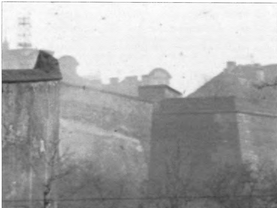
Obr. 7: Detail bastionu s hranolovým tělesem v kontaktu s gotickou hradbou, konec 19. století (AMP 1/4050).
