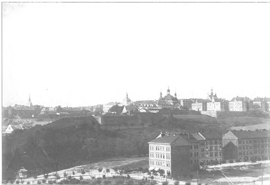
Obr. 6: Pohled na bastion s hranolovým tělesem v kontaktu s gotickou hradbou, konec 19. století (AMP 1/4050).
