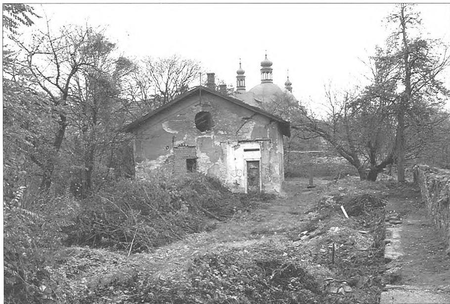
Obr. 3: Východní terasa bastionu s objektem čp. 1751/II v době zahájení rekonstrukce jižní opěrné zdi v r. 2001 a sanace náletových porostů. Foto P. Starec.
