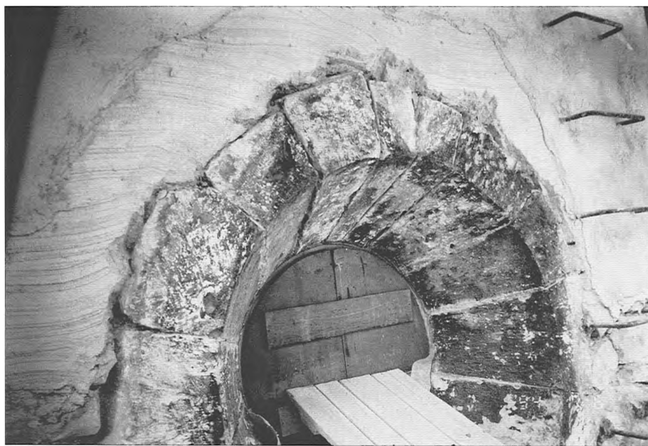
Obr. 10: Ostění kruhového okna ve východní stěně Staronové synagogy (A. Pařík, 1998).
