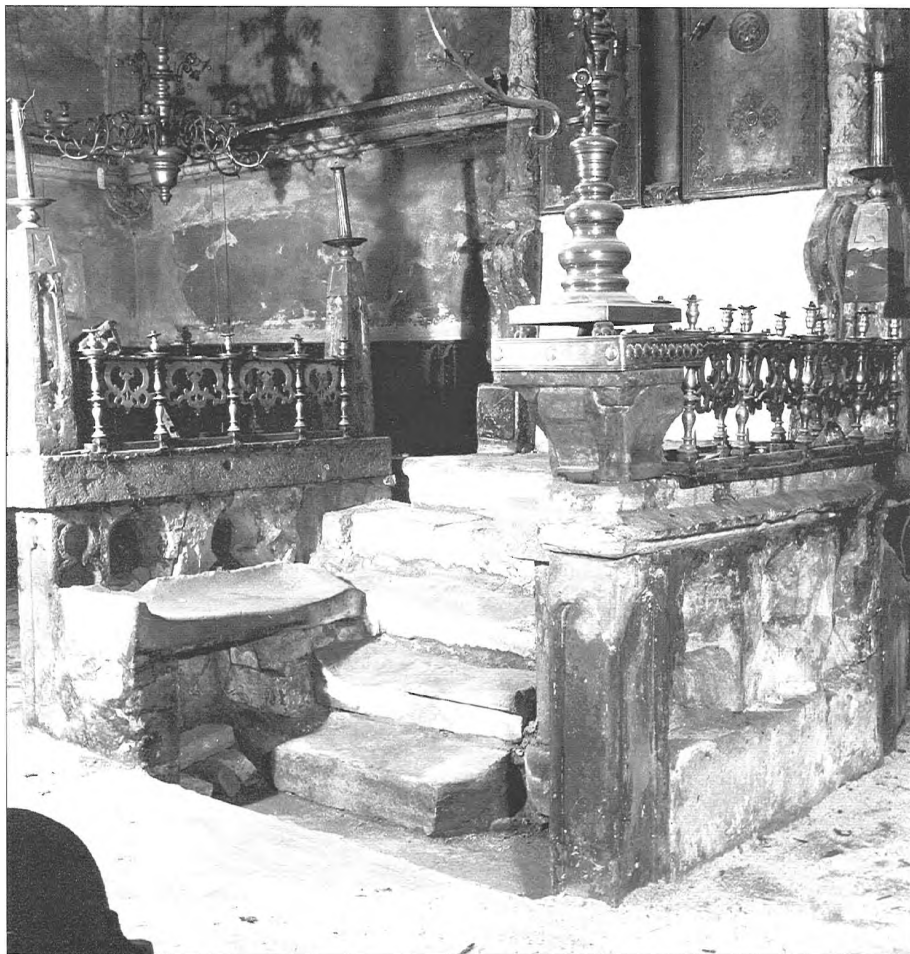
Obr. 14: Stupně ke svatostánku ve Staronové synagoze před obnovou (ŽMP 1942).
