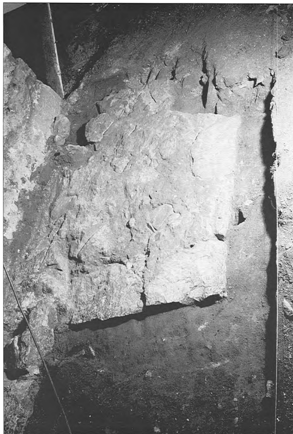
Obr. 15: Základové statické zpevnění severozápadního nároží synagogy. Pohled od východu. Foto K. Kozák.
