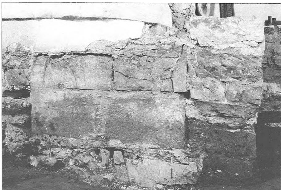
Obr. 7: Vlevo čelo středního opěráku jižní stěny synagogy s velkým pískovcovým kvádrem na rozhraní nadzemního a základového zdiva. Pod ním opukový základ. Vpravo zbytek historických terénů s patrným vkopem pro základ opěráku. Nad nimi deska dlažby a zděná lavice přiložená k východnímu boku opěráku. Foto K. Kozák.
