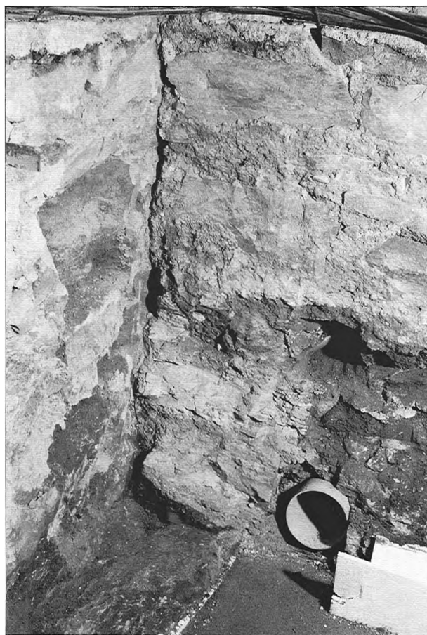
Obr. 12: Jižní zeď západního přístavku je přizděna v základové i nadzemní části k západnímu průčelí synagogy (vlevo). Pohled od severozápadu. Foto K. Kozák.
