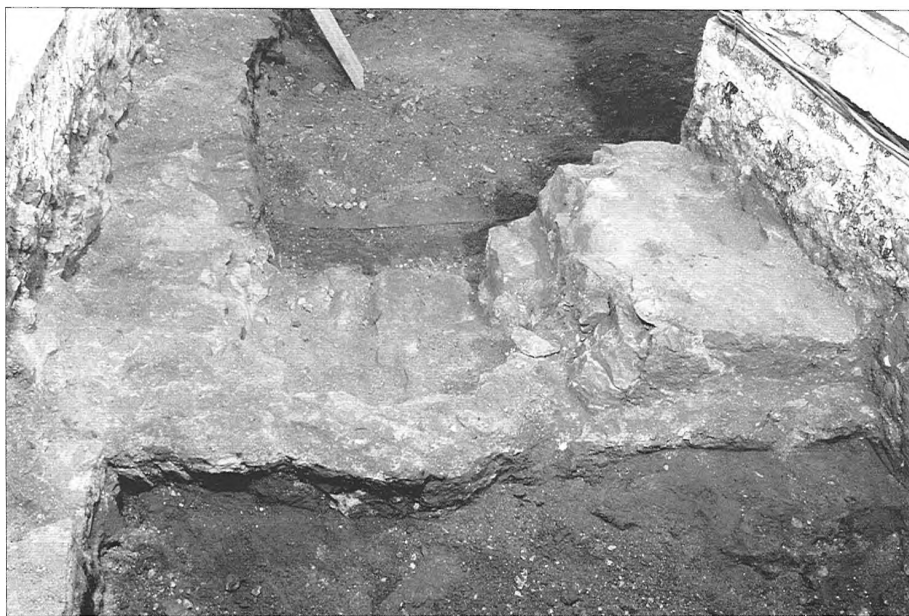
Obr. 11: Severní zeď západního přístavku, vpravo přiložena k západnímu průčelí synagogy, vlevo se lomí do západní stěny přístavku. Široký předzáklad v pozadí souvisí již se stavbou ženské lodi z r. 1732. Pohled od jihu. Foto K. Kozák.
