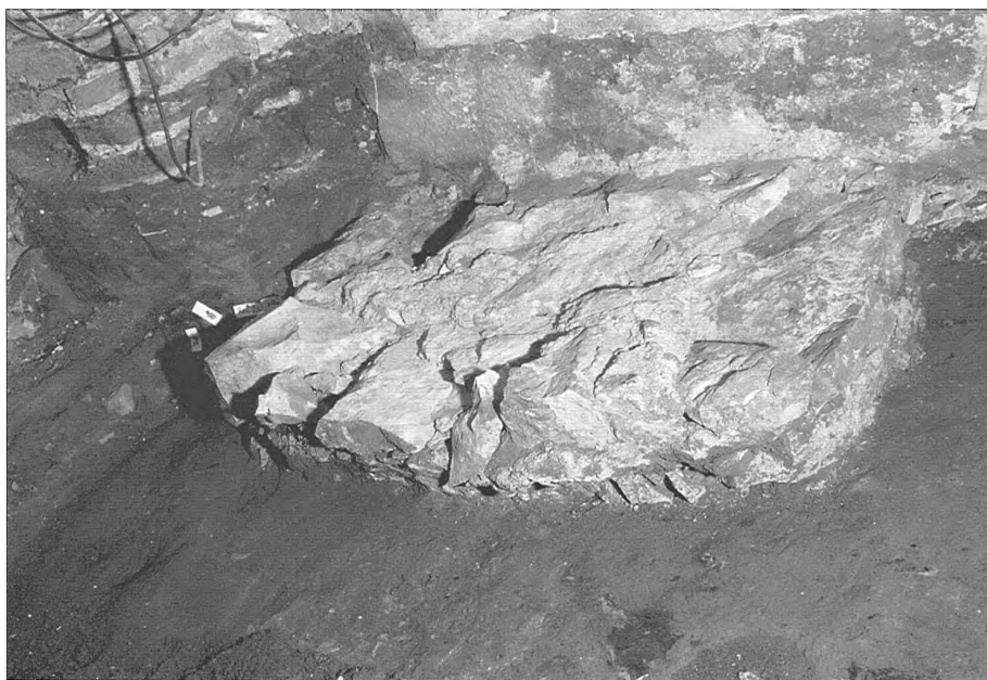
Obr. 14: Základové statické zpevnění severovýchodního nároží synagogy. Pohled od severu. Foto K. Kozák.
