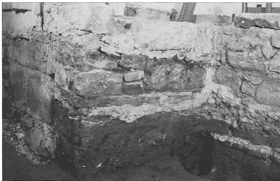
Obr. 6: Vpravo výhradně kamenné zdivo zděné lavice podél severní stěny jižního přístavku, uprostřed smíšené zdivo zděné lavice podél středního opěráku jižní stěny synagogy, spočívající na opukové dlažbě. Pohled od jihovýchodu. Foto K. Kozák.
