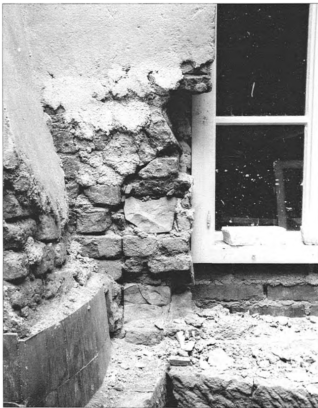
Obr. 8: Čp. 151/I. Detail hrotitého okénka spodního podlaží komory v přízemí „cihelného domu“, není vyloučeno, že torzovitě dochované zdivo může pocházet již z etapy „nedokončeného domu“ po požáru ve 40. letech 14. století.
