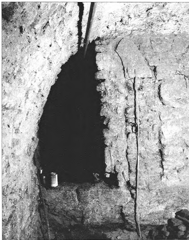
Obr. 23: Čp. 151/I, sondou očištěný fragment portálu v jihovýchodním koutě uličního sklepa. Stojka v baroku nahrazena cihlami jako výplň. Zúžení světlosti pochází již z nedokončené přestavby ve 40. letech 14. století.
