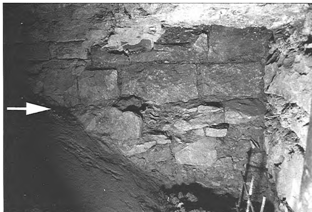
Obr. 7: Rozhraní kvádřikového a lomového v severní stěně objektu 2.
