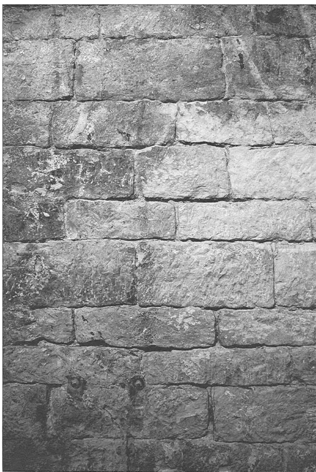
Obr. 4: Detail kvádrkové líce střední části severní stěny objektu 2.
