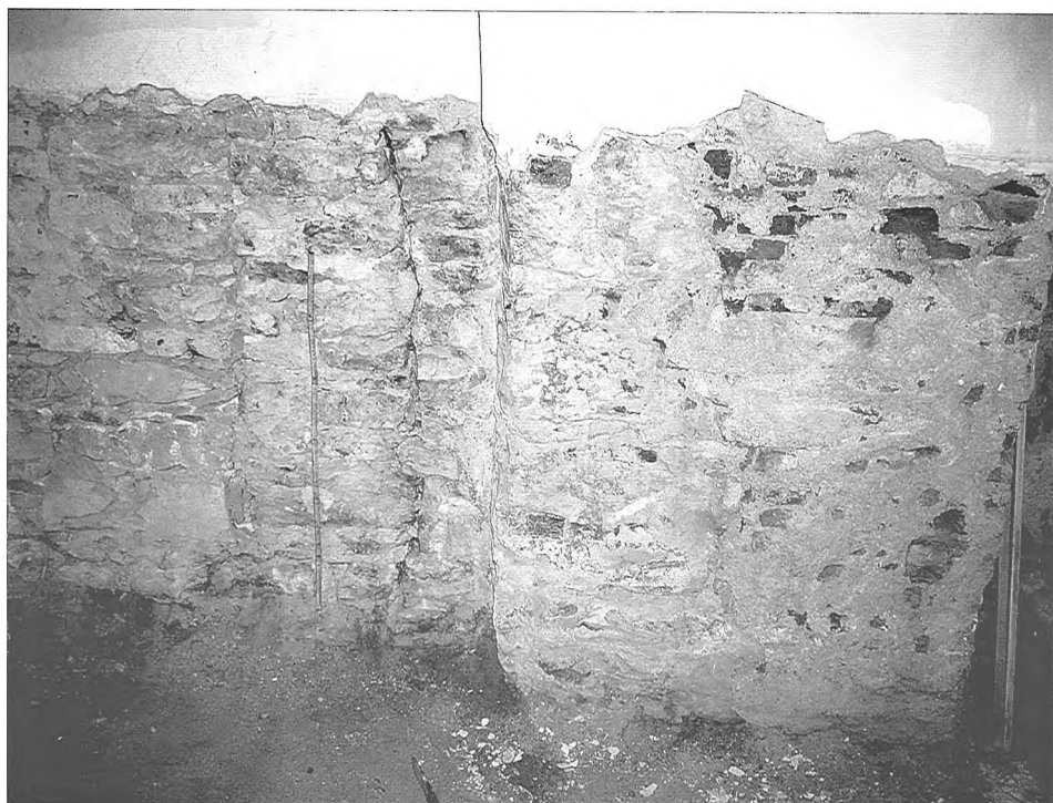
Obr. 6: Detail arkády přízemí východní stěny průjezdu čp. 249/III s předloženým polopiliřem. Foto M. Kovář.
