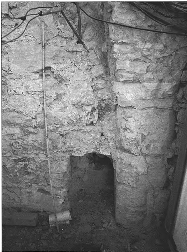
Obr. 7: Detail východní parcelní zdi čp. 249/III přízemí s patrným piliřem a výběhem pasu. Foto M. Kovář.
