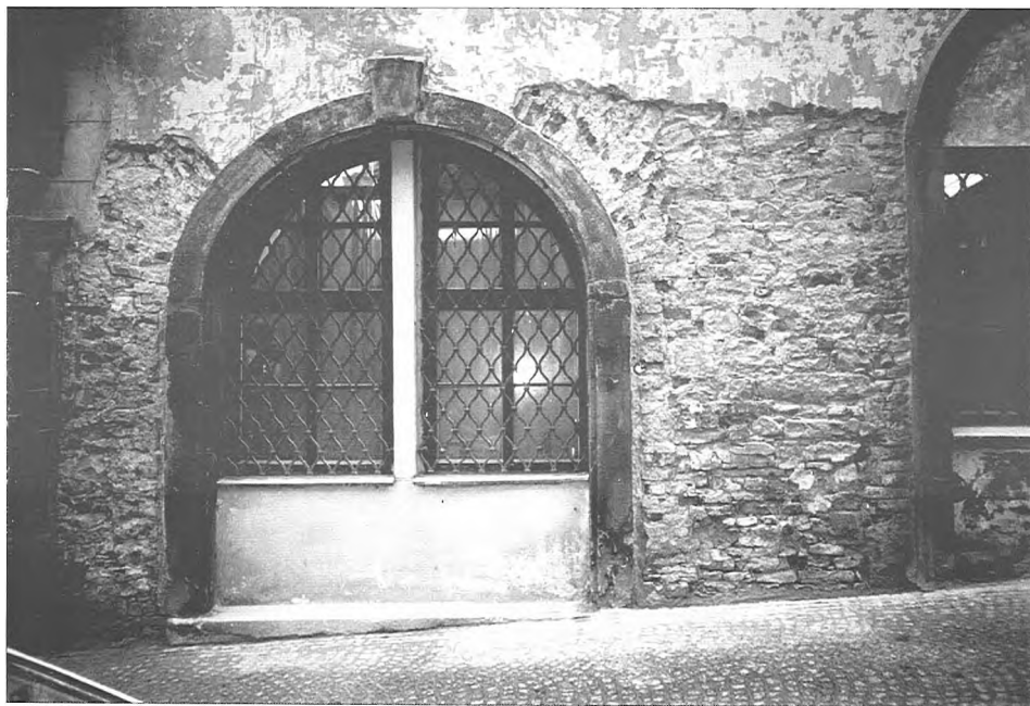
Obr. 5: Pohled na průčelní fasádu čp.249/III v místě styku dvoutraktů. Foto M. Kovář.
