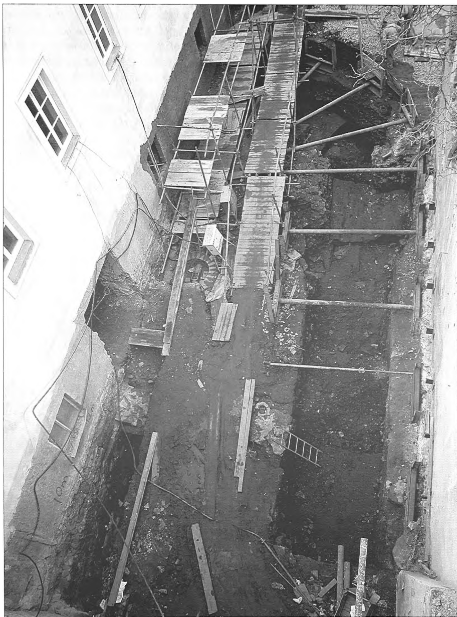
Obr. 9: Praha 1-Malá Strana, Nerudova ulice čp. 249/III, západní dvůr domu (sektor E) s výkopem pro příjezdovou rampu do podzemních garáží, pohled od východu. Foto J. Hlavatý.
