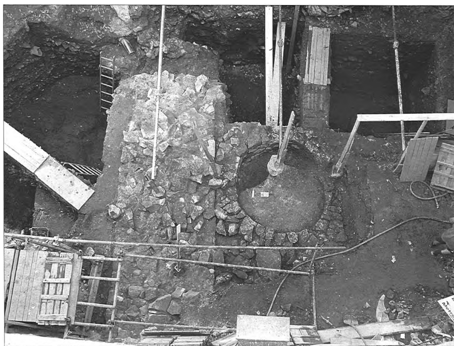
Obr. 10: Praha 1-Malá Strana, Nerudova ulice čp. 249/III, západní dvůr domu (sektor E). Pohled na odkrytou korunu hradební zdi z lomové opuky. K východní lici zdi se nalézá dodatečně přizděná pozdně středověká studna náležející k pozdější městské zástavbě. Foto J. Hlavatý.
