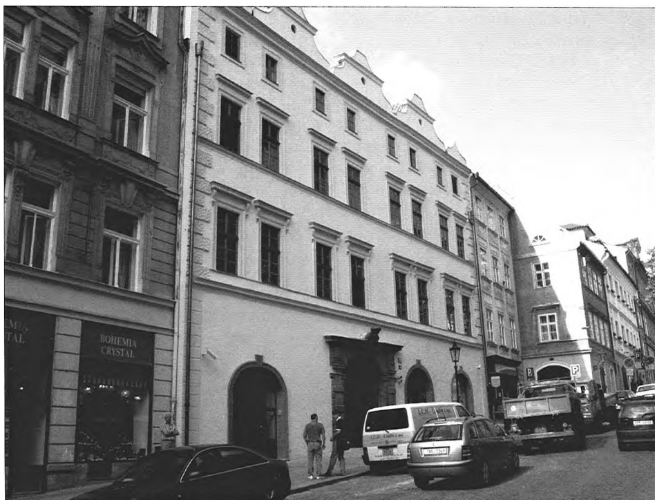
Obr. 2: Dům čp. 249/III v Nerudově ulici, severní průčelí. Foto J. Hlavatý.
