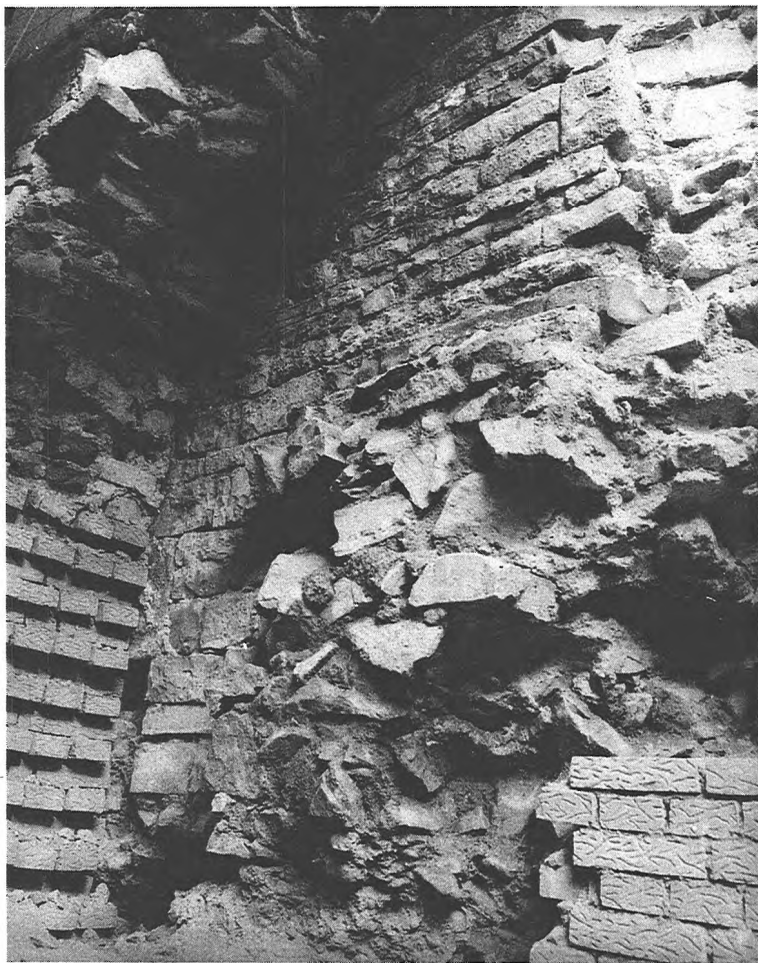
Kvádříková líc západní stěny románské stavby s vertikálně sestupujícím předzákladem. Pohled od jihozápadu. (V. Kvapil)
