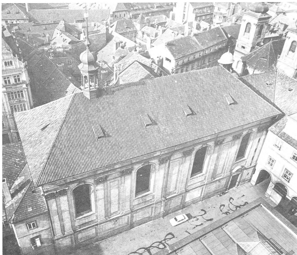
Kostel sv. Klimenta, pohled na severní fasádu z astronomické věže Klementina. (H. Šantl)
