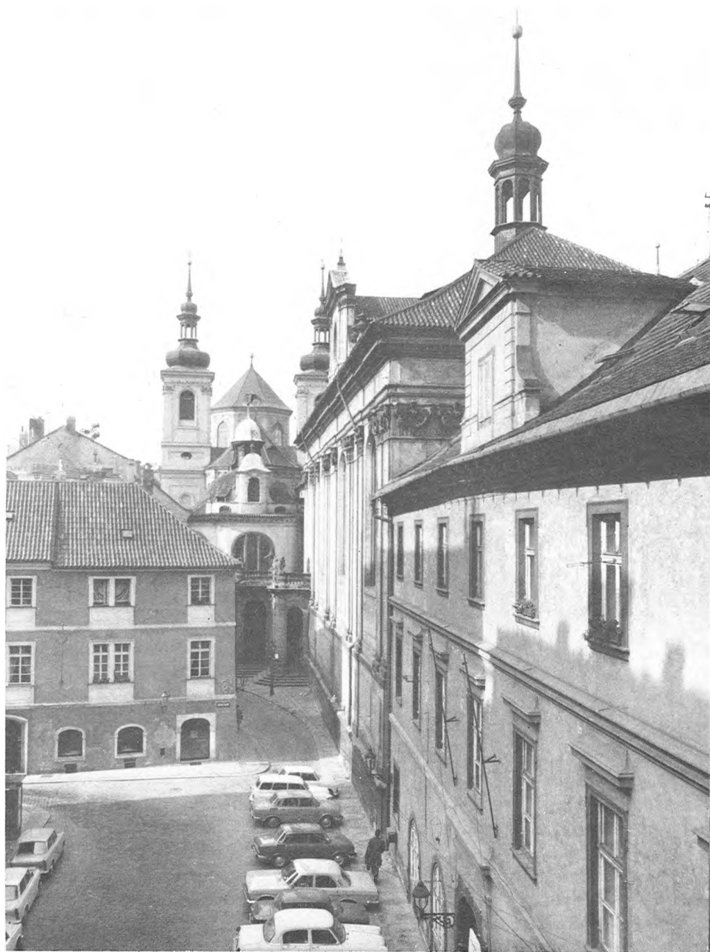
Průhled Karlovou ulicí od východu na portikus, Vlašskou kapli a kostel sv. Salvátora. Vpravo jižní fasáda sv. Klimenta. (J. Janatková)
