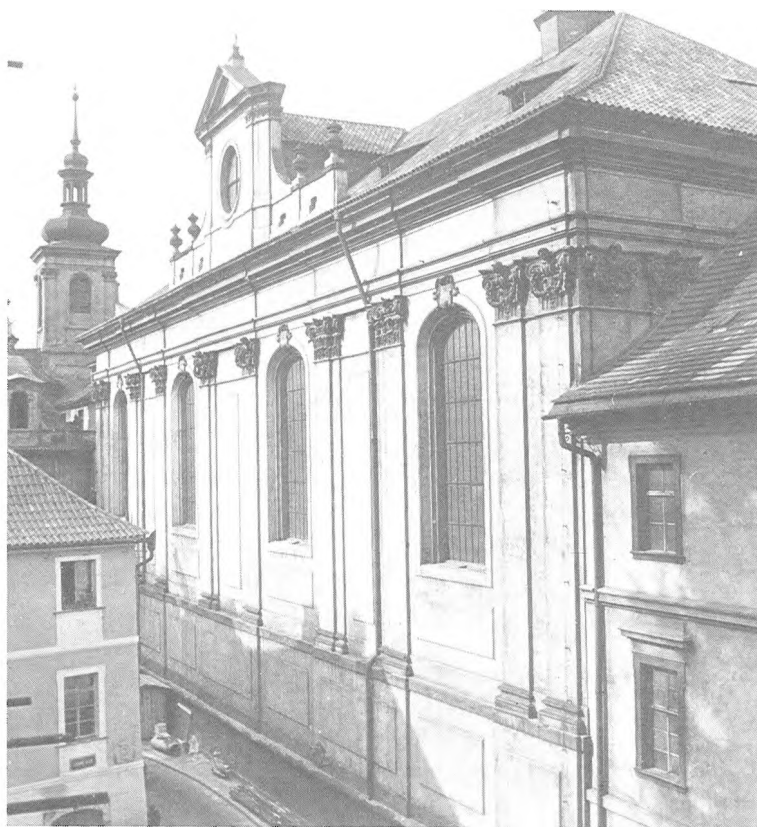
Kostel sv. Klimenta, jižní průčelí. (H. Šantl)
