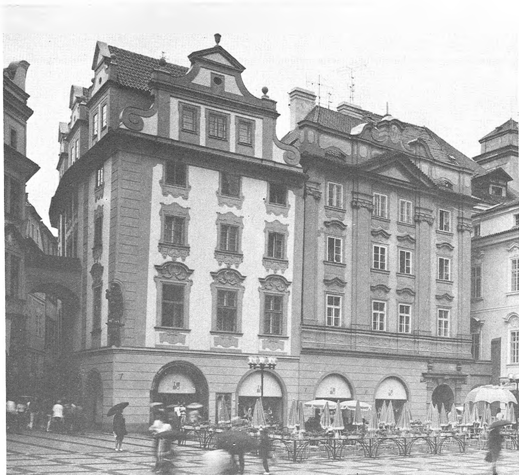
Čp. 461/I – Vilémkovský dům – Původně měšťanský dům, později připojený ke klášteru servitů u sv. Michala, gotický v suterénu a části obvodového zdiva, přestavěn renesančně a barokně v souvislosti s připojením ke klášteru, pozoruhodná barokní fasáda, v zadní části radikální novodobé zásahy v l. 1934–1935. Vpravo čp. 462/I – U vola – Původní měšťanský dům s gotickým suterénem a částmi zdiva. V 17. a 18. století spolu s klášterem upraven barokně. Velmi hodnotná fasáda na přechodu do Melantrichovy ulice, kde je propojena prampouchem s čp. 478/I. Na nároží kopie vrcholné barokní plastiky sv. Josefa od Lazara Widmana z doby po r. 1750. (R. Maleček)
