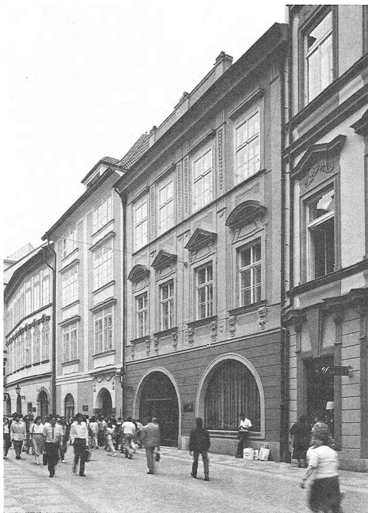
Čp. 559/I – Bubnovský dům – Pochází z druhé poloviny 14. století. Zachované gotické zdivo od dvoupodlažních sklepů až po 2. patro a pět malovaných záklopových stropů ve 2. patře ze 17. století, kdy byla upravena fasáda a vybudováno palácové schodiště. Další přestavby v 18. a 19. století se týkaly především dvorních křídel. V interiérech zavěšeny fragmenty pozdně renesančních maleb, přenesených z čp. 562/I. (R. Maleček)
