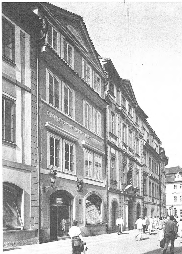
Čp. 593/I – U červeného orla – Dům je provozně propojen s čp. 594/I. Zachovány sklepy se studnou ze 14. století a pět malovaných záklopových stropů z přestavby v 17. století. Na fasádě empírové výzdobné prvky a domovní znamení – červený orel – z konce 18. století. V domě, v kavárně U Suchých, se v zimě r. 1833–1834 seznámil Karel Hynek Mácha s Lori Šomkovou (R. Maleček)
