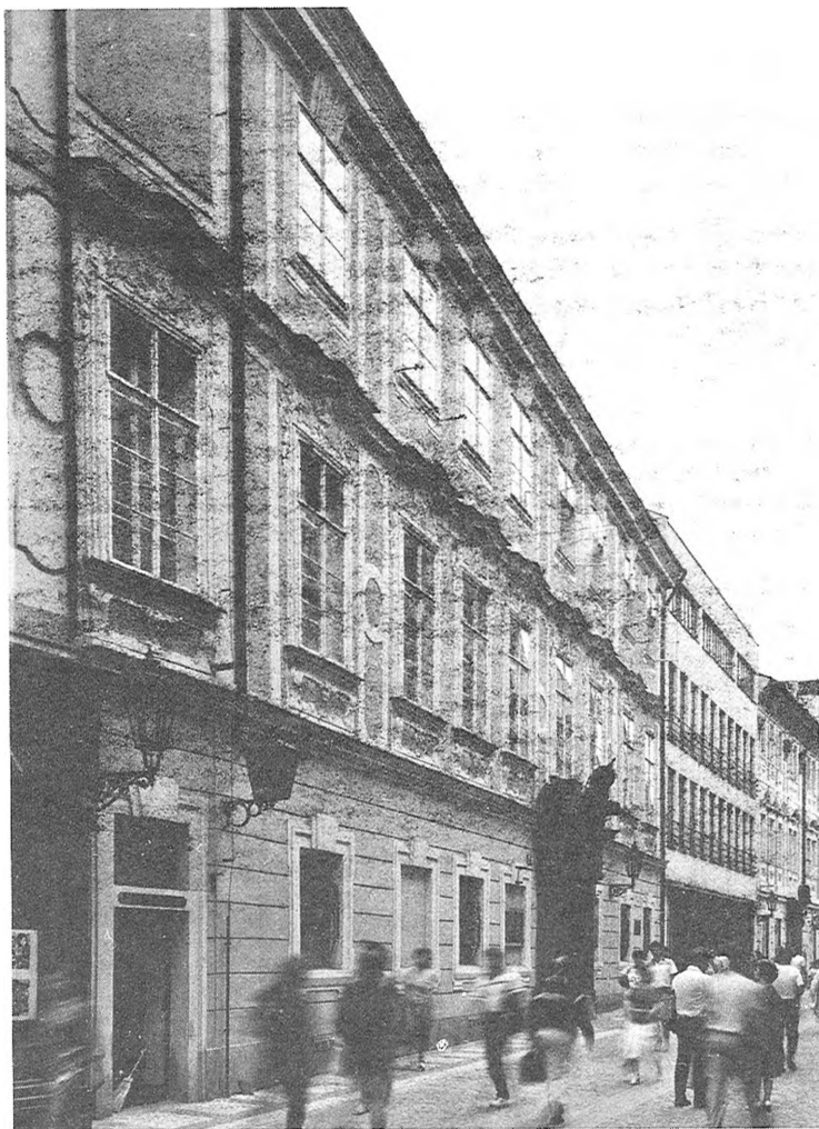
Čp. 597/I - palác Caretto-Millesimovský - Palác zbudovaný v polovině 18. století s použitím zdiva gotického domu ze 14. století snad architektem Anselmem Luragem. V objektu zachovány významné detaily středověkého objektu. Stavební zásahy v r. 1924, adaptace a zastřešení nádvoří po r. 1950. Vynikající architektura zdůrazněná plasticky bohatě členěným portálem s millesimovským znakem. (R. Maleček)
