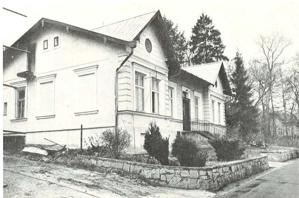
Budovy bývalých lázní (dnes součást Kojeneckého ústavu).
