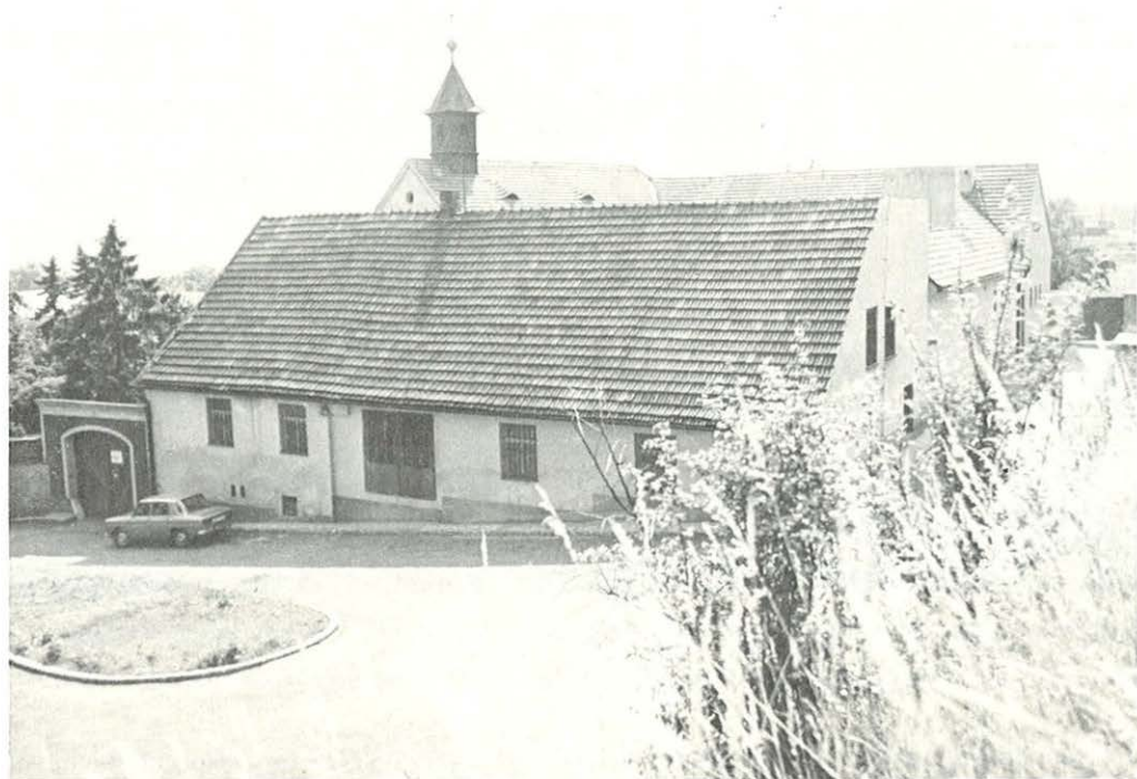
Smíchov, usedlost Horní Palata čp. 110, původně hospodářská usedlost mezi zahradami na jižním svahu Strahova.
