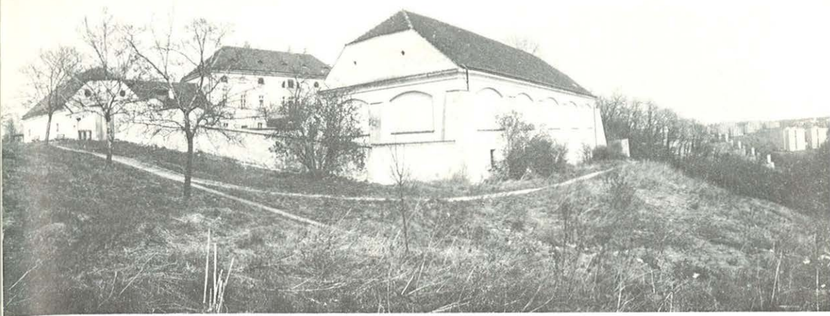
Košíře, usedlost Šmukýřka čp. 724, hospodářská usedlost doložená od počátku 18. století. Hlavní budova upravovaná okolo roku 1800, v zahradě salla terrena a kaple sv. Prokopa.
