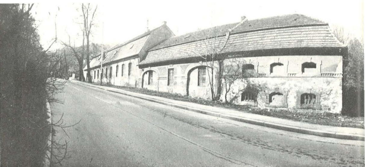
Hospodářská stavení při usedlosti Turbová — Košíře čp. 731 — bývalá viniční usedlost s terasovou zahradou.
