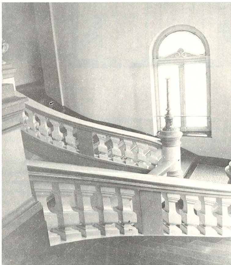
Trojramenné schodiště žižkovské radnice.
