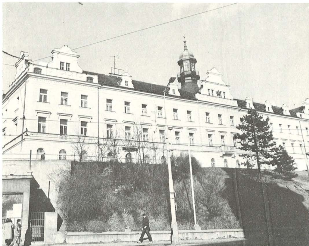
Radnice ve Vršovicích, vzniklá přestavbou dvou starších domů.
