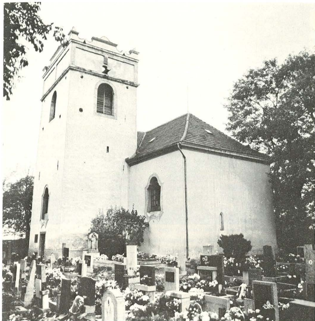
Kostel v Kralovicích, pohled od jihovýchodu. Snímek z roku 1987.
