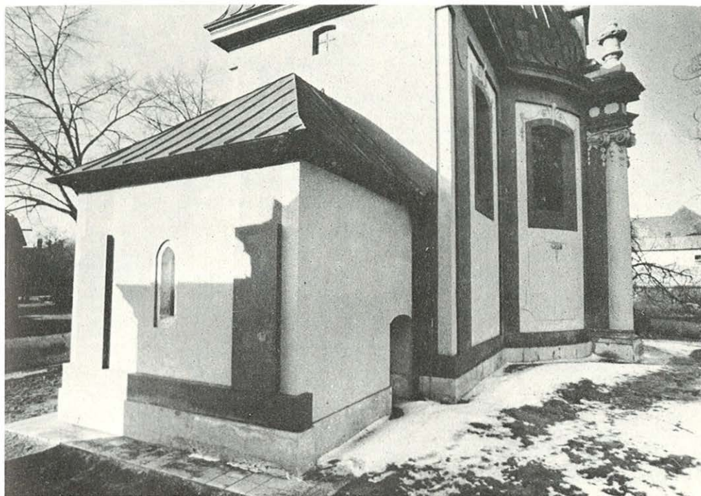
Kostel v Kunraticích. Sakristie — původní gotický chór, pohled od severovýchodu. Snímek z roku 1987.
