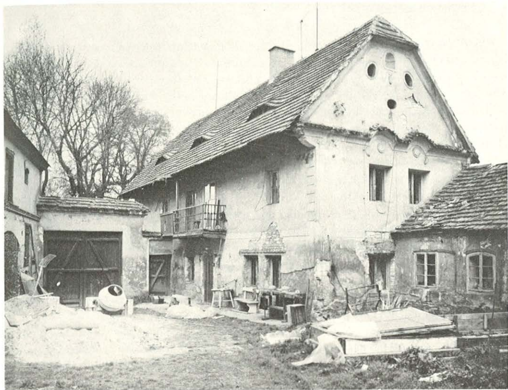
Pohled ze dvora na dům usedlosti čp. 5.
