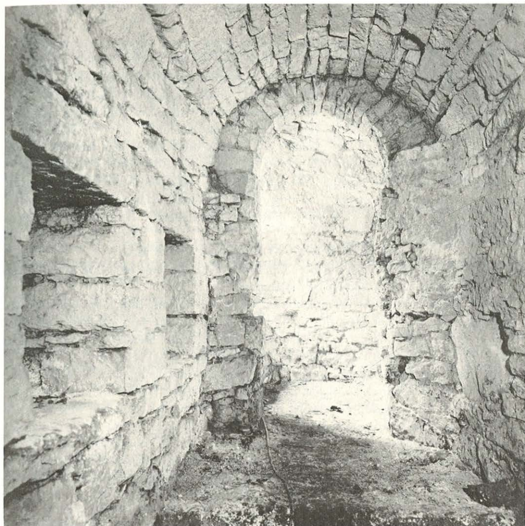
Sestup ke sklepu v hospodářském objektu ve dvoře usedlosti čp. 15, ukázka typického opukového zdiva.
