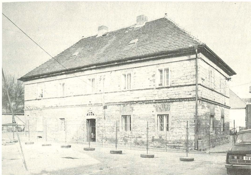
Pohled ze dvora na vstupní průčelí domu usedlosti čp. 19 z poloviny 19. století.
