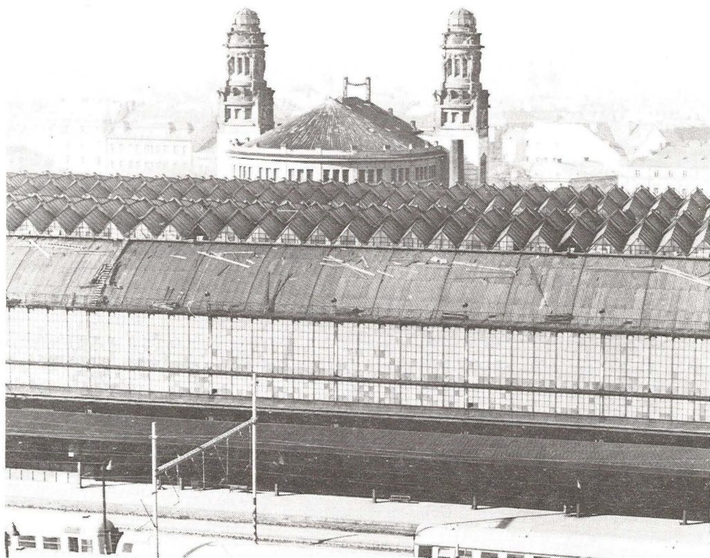
Hala hlavního nádraží nad kolejí
