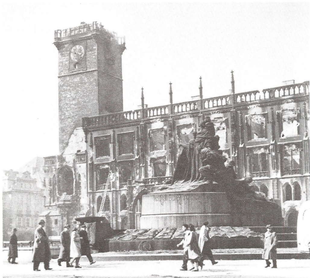
Nobileho křídlo po požáru
