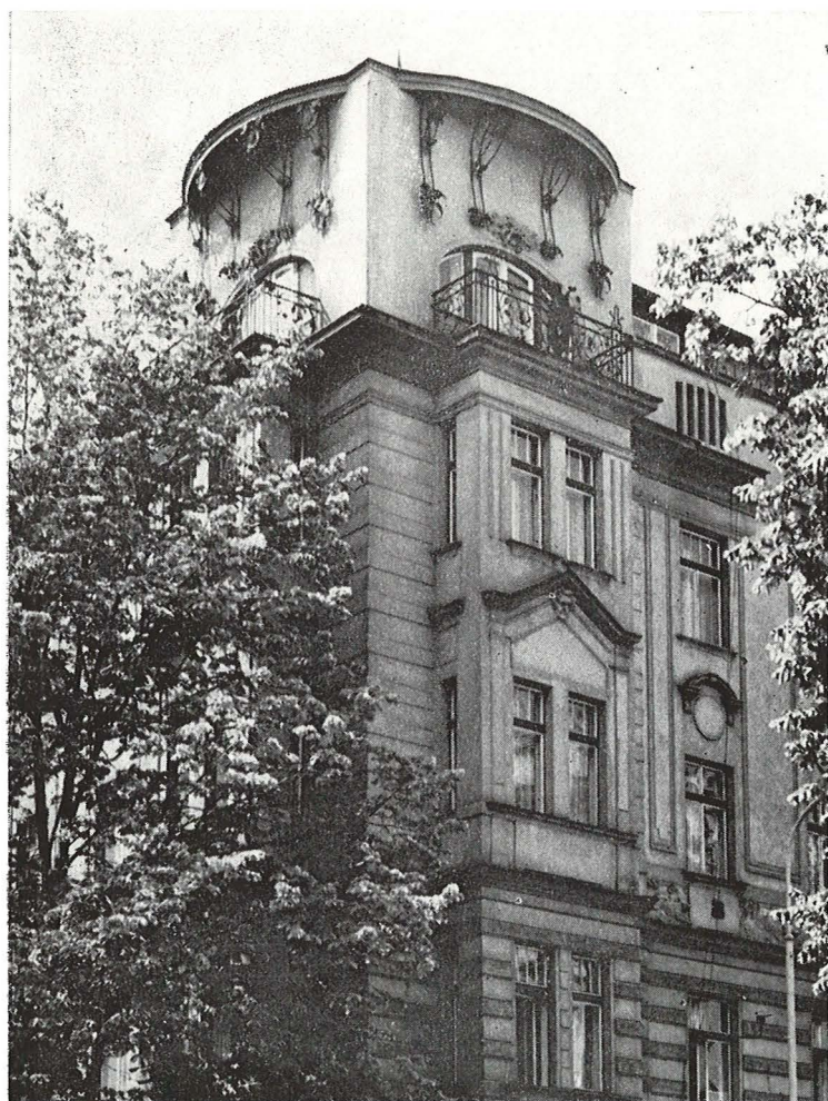
Detail nárožní věže domu v Urxově ulici v Praze – Karlíně, 1902
