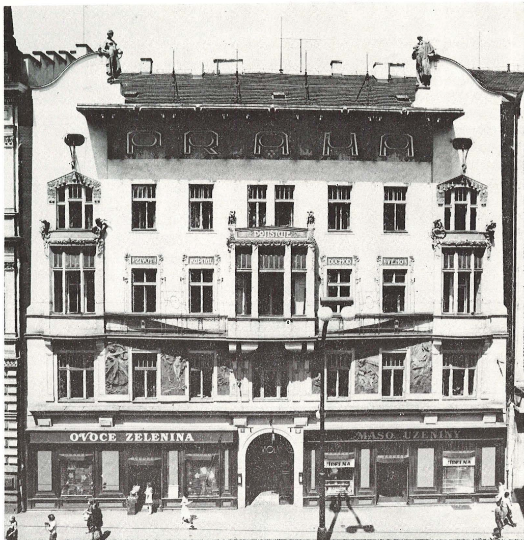
Průčelí bývalé pojišťovny Praha v roce 1986
