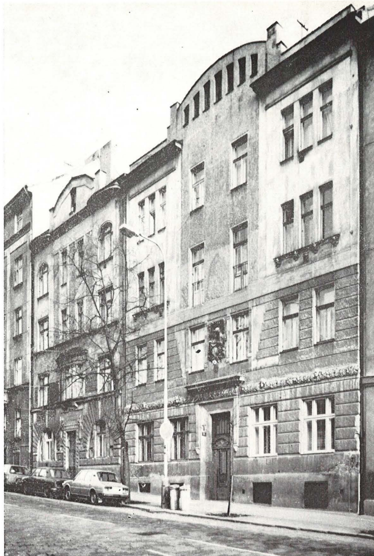
Dům čp. 470/XIII, Ruská 6, po odstranění balkónu
