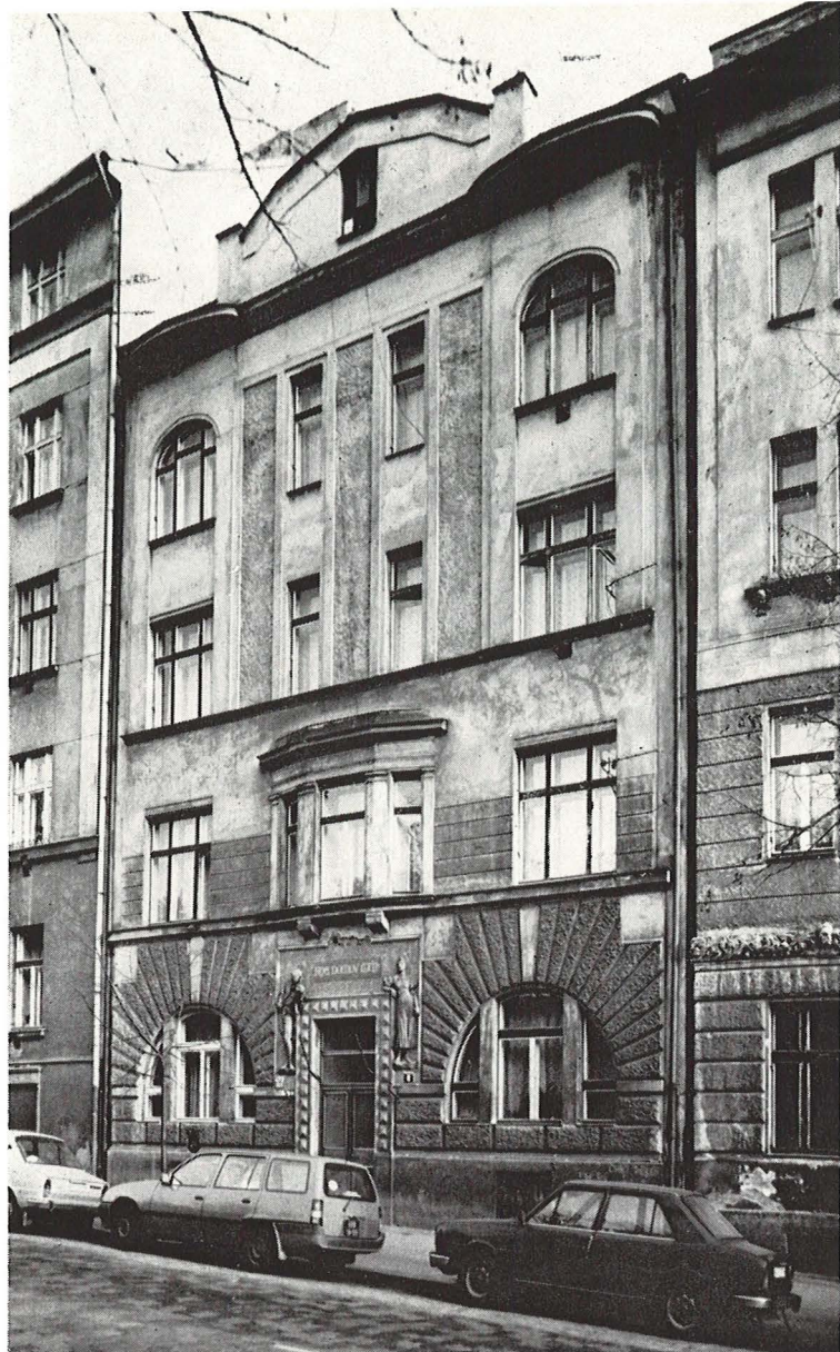
Dům čp. 473/XIII, Ruská 8, „Kde domov můj“, průčelí degradováno výměnou vstupních dveří za celokovové
