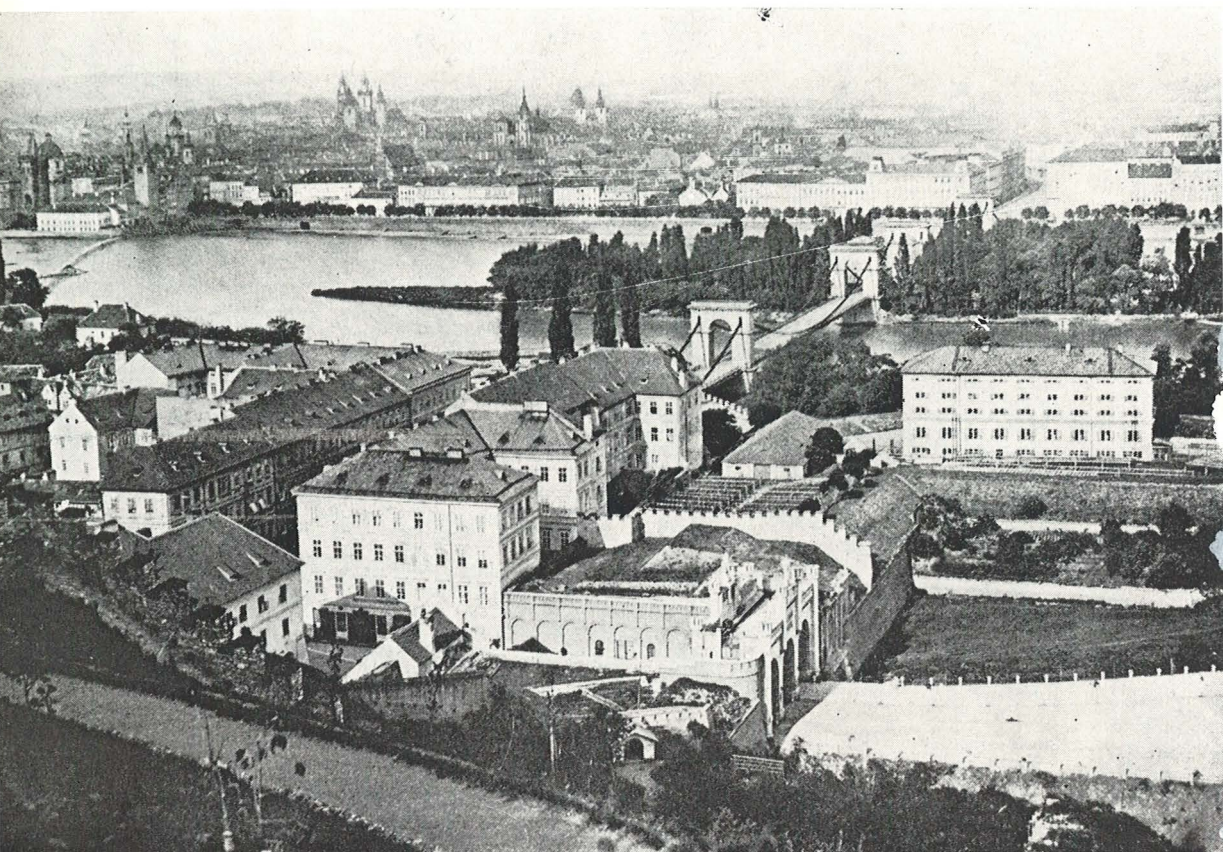
První významný novodobý architektonický soubor vyrostl na břehu Vltavy při řetězovém mostě, jehož pravobřežní předmostí vyvrcholilo stavbou Národního divadla
