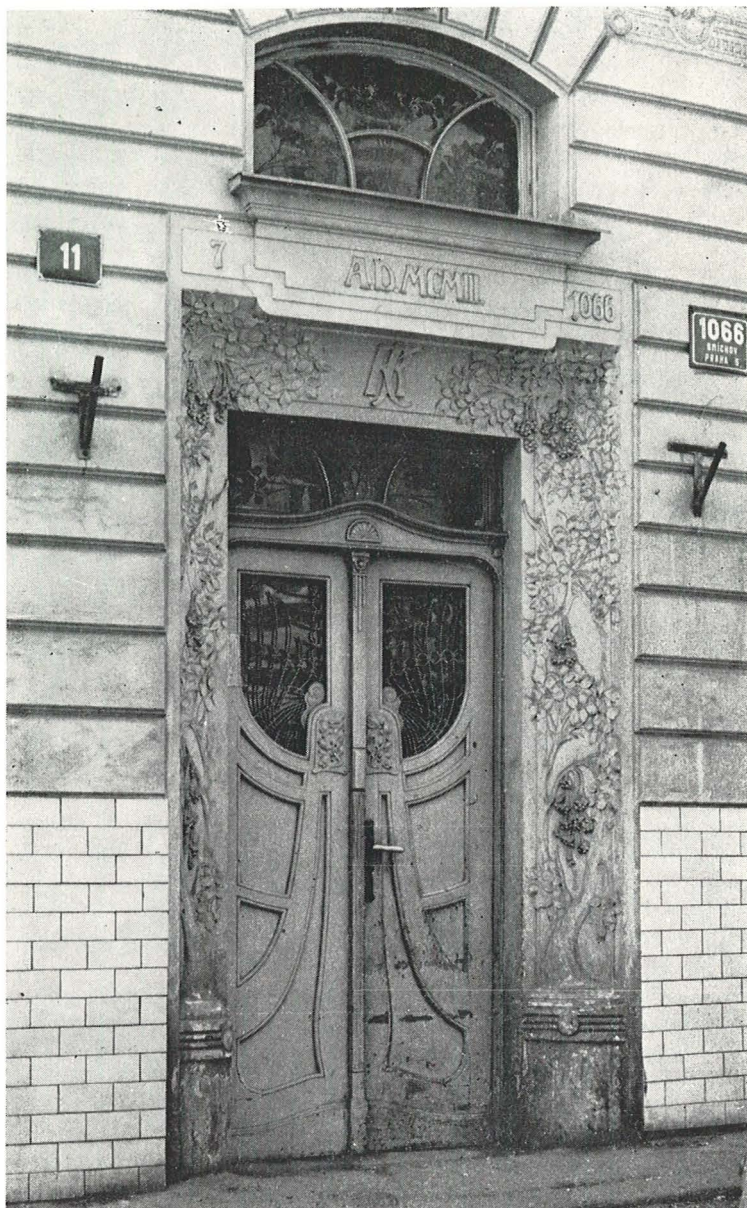
Čp. 1066 na Smíchově, ul. P. Švandy 11
