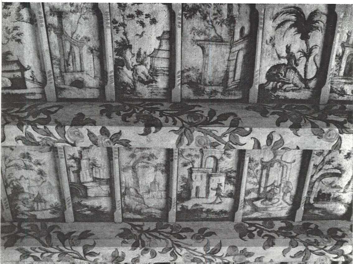
Malovaný záklopový strop, rokokový typ s prvky chinoiserii, čp. 149/I Karlova ulice
