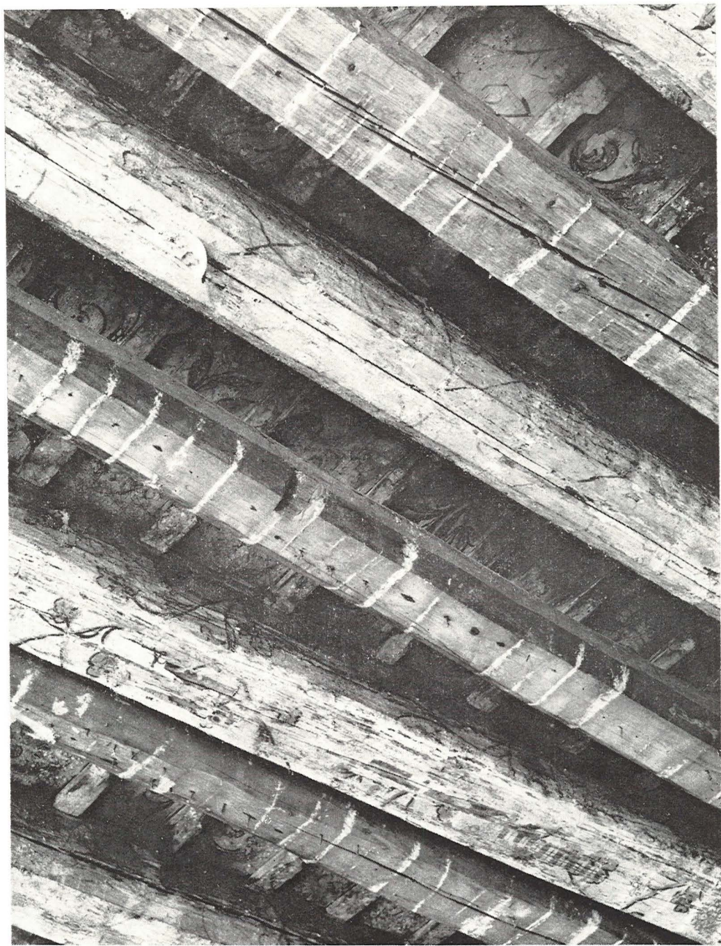
Malovaný záklopový strop v Buquoyském paláci datovaný rokem 1610. Stav před restaurováním
