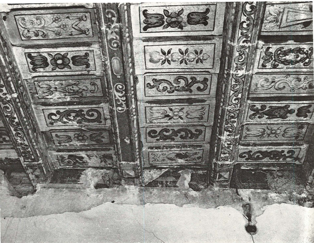
Malovaný záklopový strop ze 17. století, čp. 386/I Na můstku
