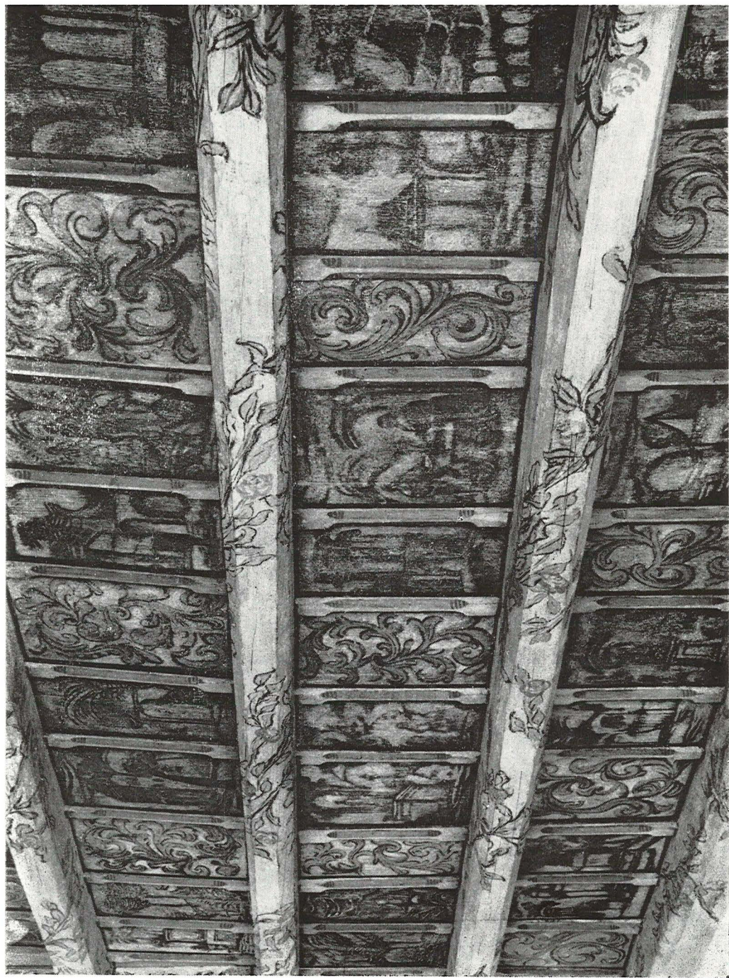
Malovaný záklopový strop z 18. století, čp. 149/I Karlova ulice
