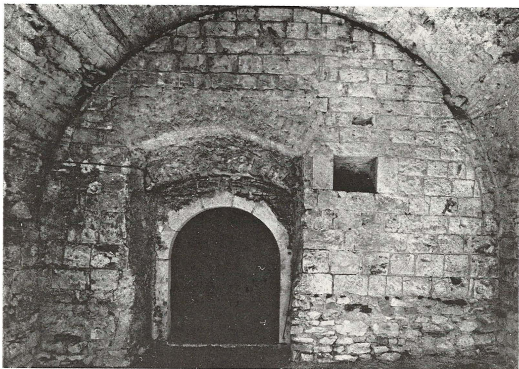
Západní zeď východní prostory románského domu s charakteristickým výklenkem a mladším portálem. Lomové zdivo s řadou drobných otvorů ve spodní partii náleží gotickému prohloubení interiéru. Vpravo patrná úprava klenebního čela, na klenbě otisky šalování
