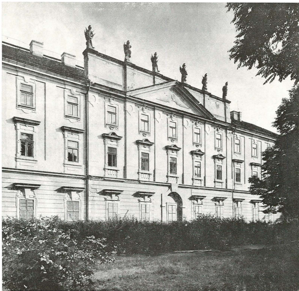
Invalidovna – hlavní průčelí
