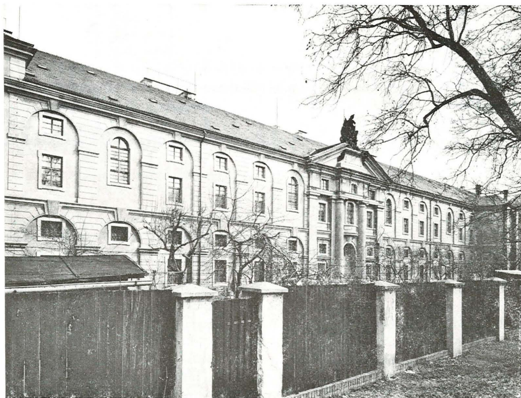
Rizalit vnitřního východního dvora – současný stav
