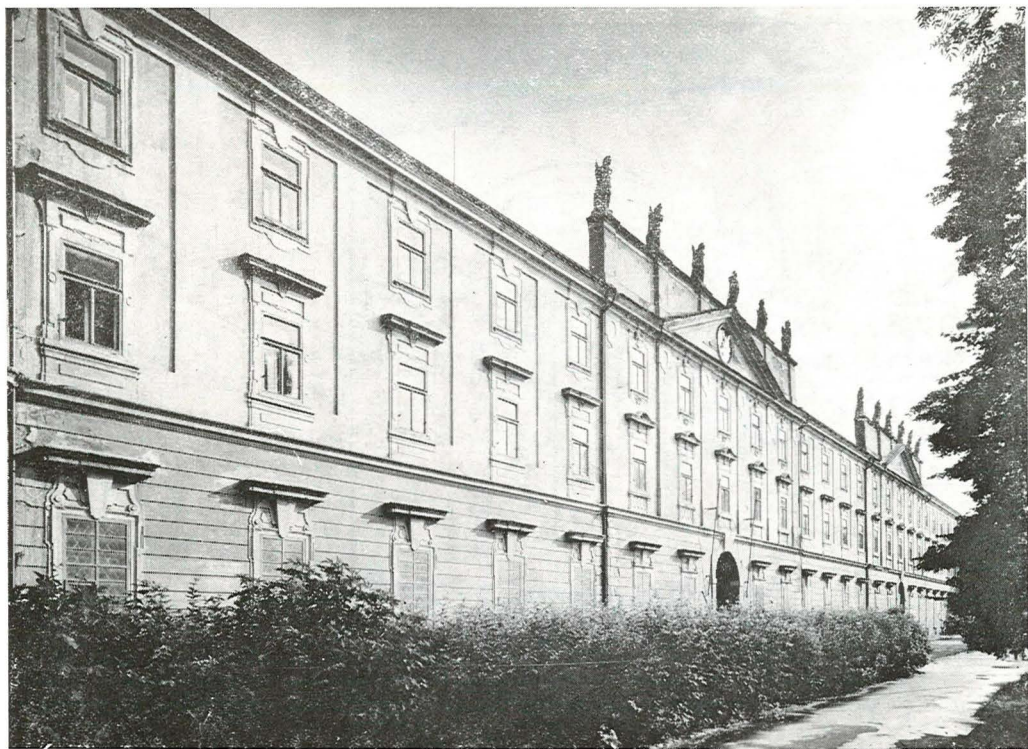
Severní rizalit – současný stav
