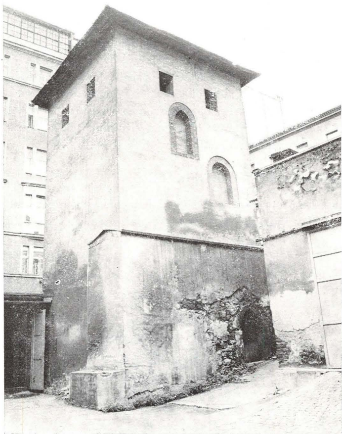
Věž staroměstského opevnění na dvoře domu čp. 310/I – pohled od severovýchodu
