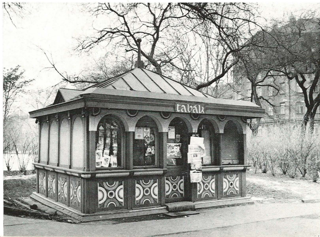
Rekonstruovaný kiosek v Bolzanově ulici
