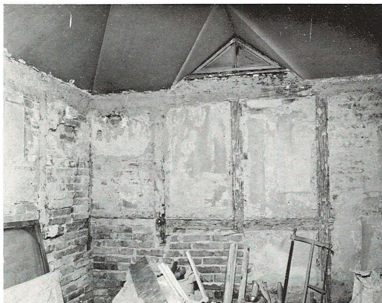
Detail interiéru během rekonstrukce
