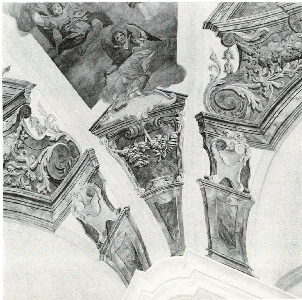
Členění stropu s dekorativní výzdobou
