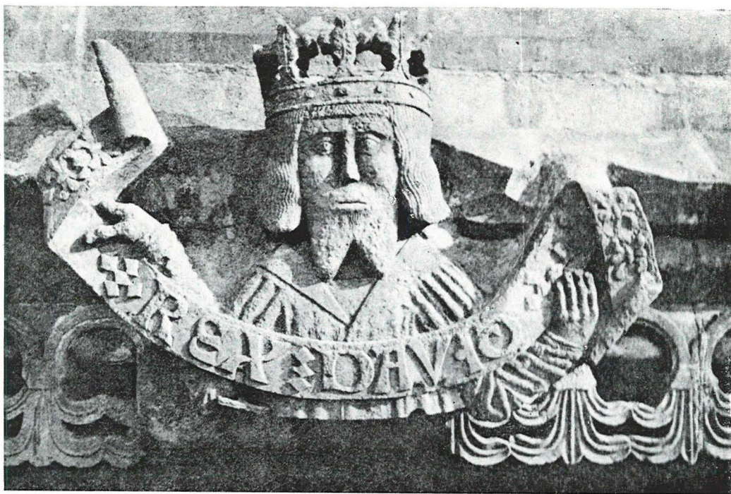
Římsa pod ochozem jižní věže – král David – škola Matěje Rejska, před rokem 1511. Stav z počátku 20. století před odpadnutím pravé části plastiky. Doplněna při současné obnově exteriéru
