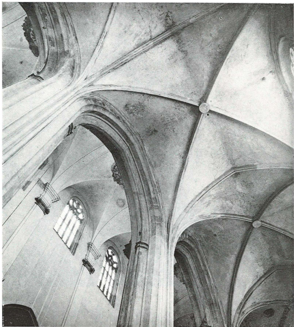
Klenby severní boční lodi s průtahem do kleneb hlavní lodi
