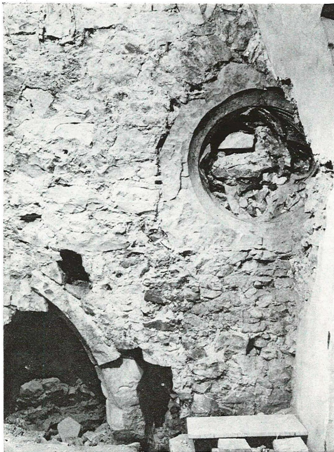
Přízemí severní fasády čp. 385 s rozetou a s jedním z bočních otvorů (oken?)
