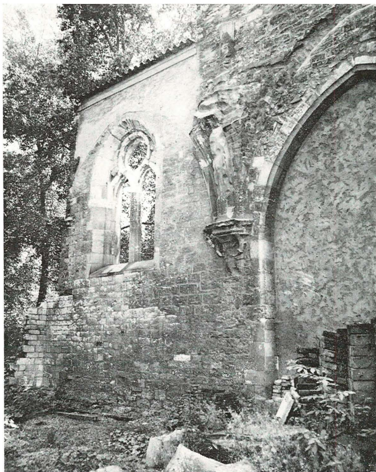
Okno v jižní stěně východního pole jižní lodi kostela sv. Františka.
