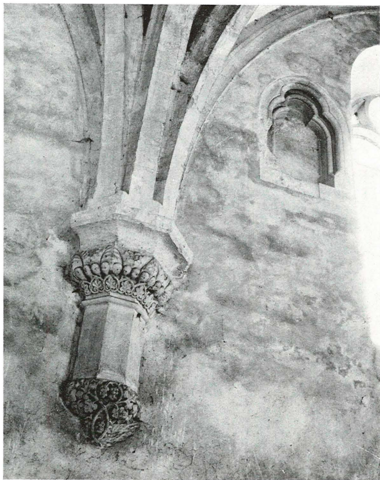
Konzola a žebra na severní straně kostela sv. Salvátora. Vpravo patrný odkládací výklenek na úrovni 1. patra
