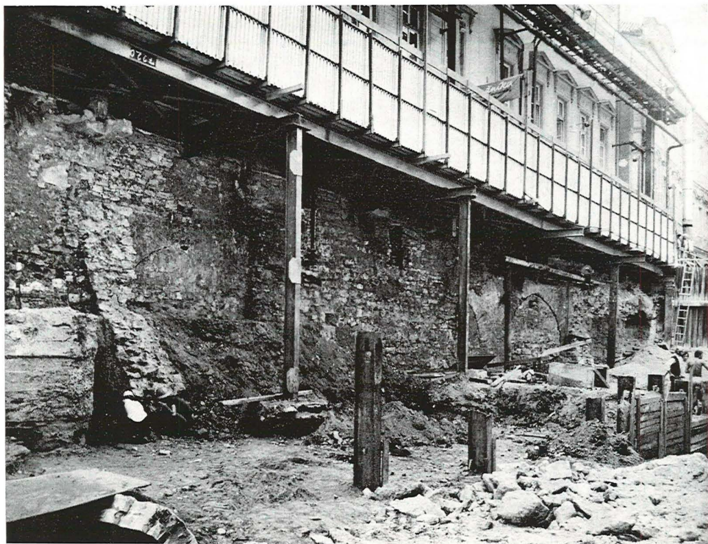
Výzkum staveniště Na můstku – řez příkopem se zbytky mostu a vyzdivky příkopu
