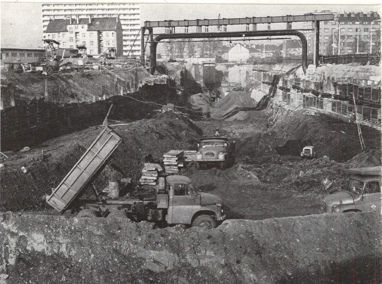
12. Výkop pro stanici metra Mládežnická, kde byl proveden záchranný výzkum silurských souvrství pracovníky Ústředního ústavu geologického v Praze
