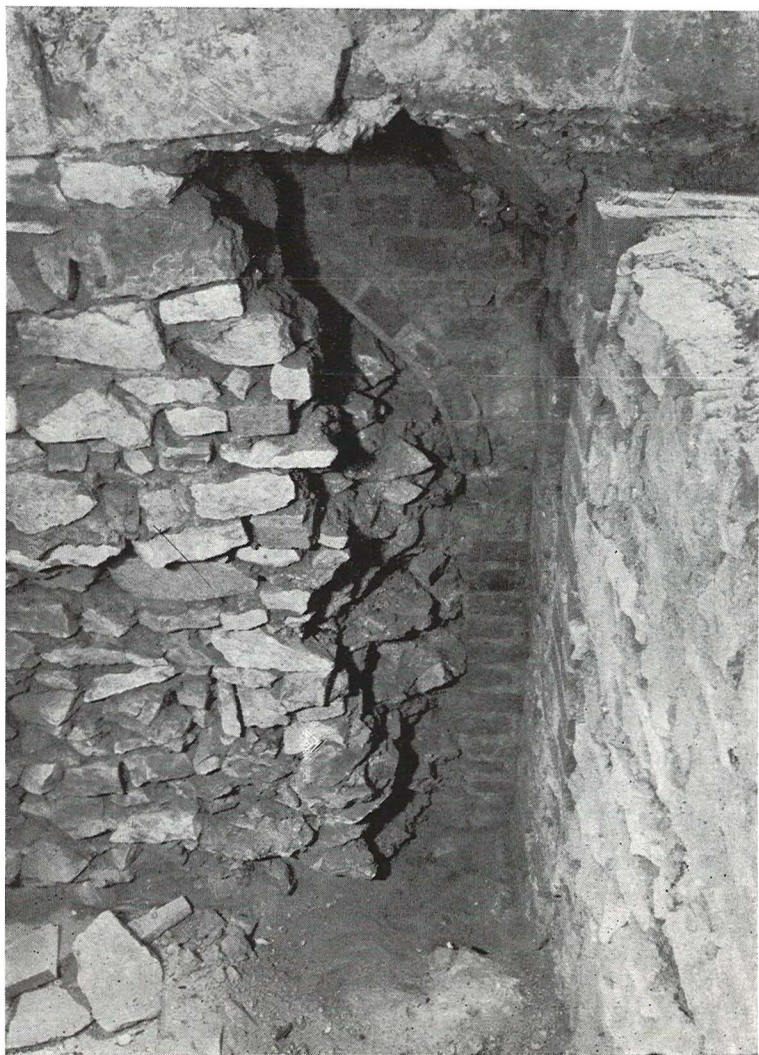
Novoměstská radnice – část portálu objeveného pod východní zdi mázhausu – pohled od západu
