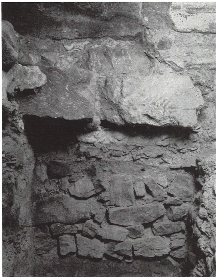
Novoměstská radnice – úsek starší zdi pod základy severní obvodové zdi mázhausu – pohled od jihu
