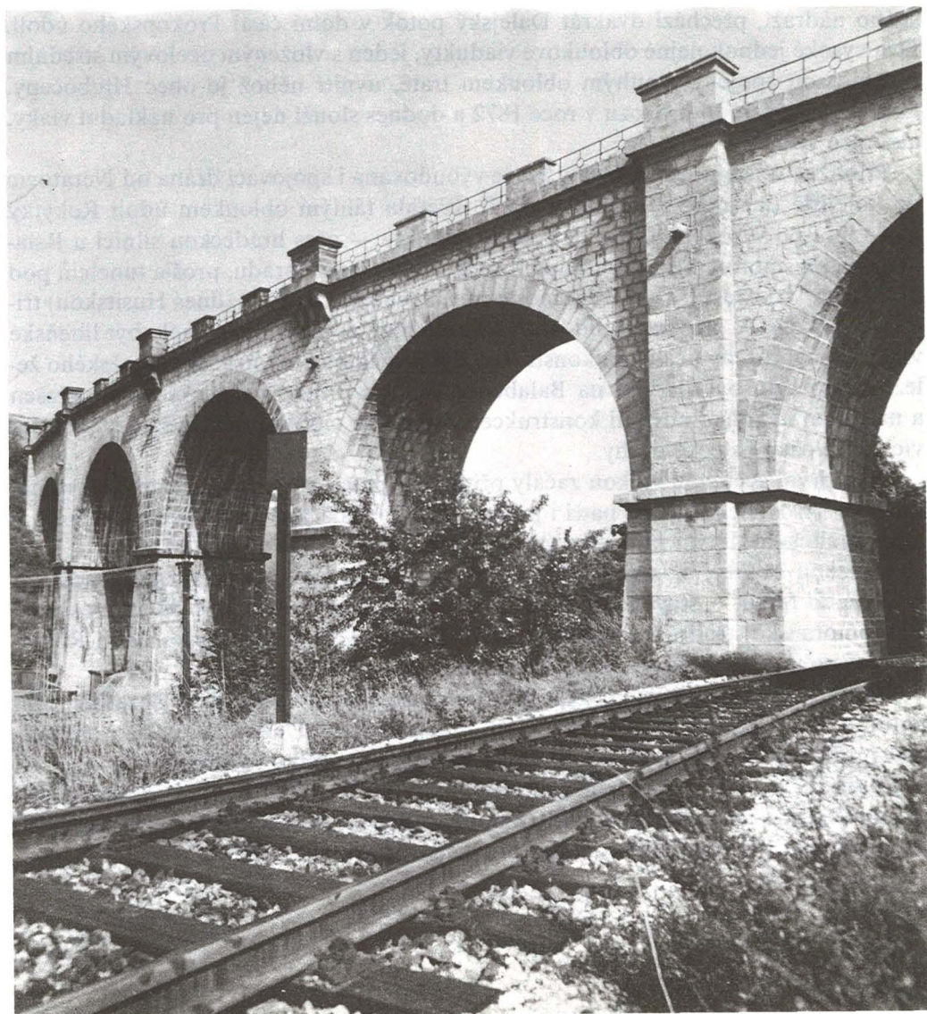
Horní viadukt býv. Buštěhradské dráhy v Hlubočepích
