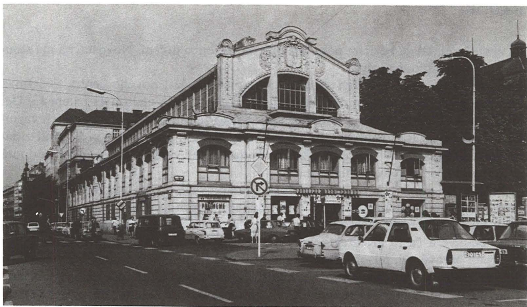
Smíchovská tržnice, celkový pohled
