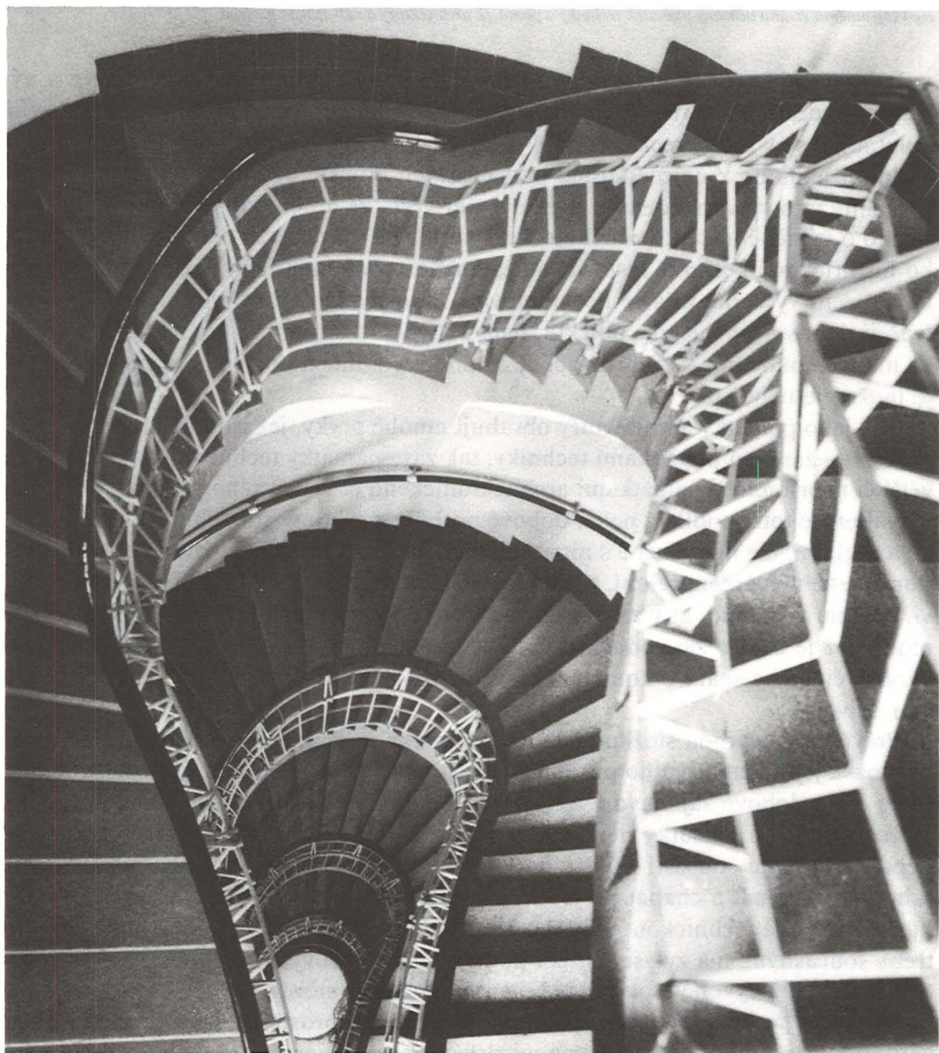
Čp. 569/I. U černé matky boží, hlavní schodiště
