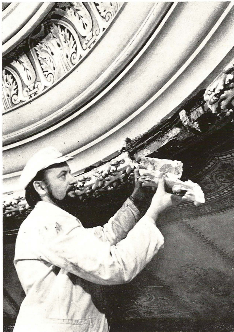
Oprava štukatury na stropě Dvořákovy síně Domu umělců (snímek H. Šantl)
