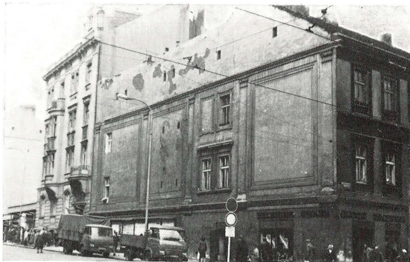
Nároží ulice Nádražní a Bozděchovy před demolicí (čp. 27 a 28)
