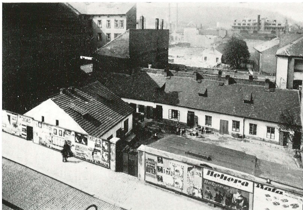
Pohled z Bozděchovy ulice k Plzeňské třídě — dvorní zástavba domů čp. 25, 26, 27 a 344 kolem roku 1930
